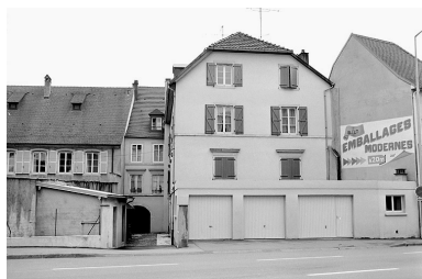
Vue d'ensemble depuis le boulevard périphérique. Phot. Jérôme Mongreville IVR43_19872500878X
