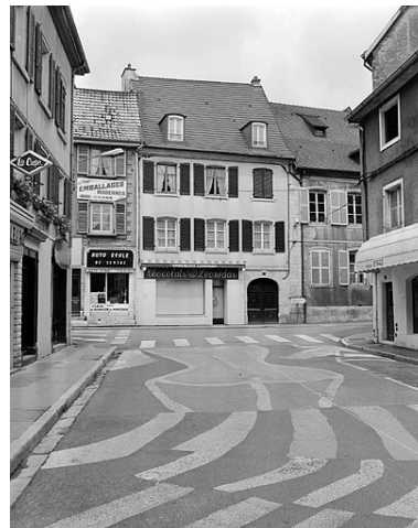
Façade sur rue. Phot. Jérôme Mongreville IVR43_19872500321X
