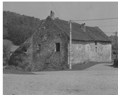
Face postérieure et face droite. Phot. Dominique Dominguez IVR43_19803900026X
