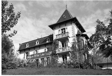
Face latérale gauche. Phot. Yves Sancey IVR43_19802501121X
