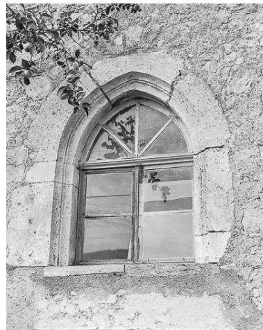
Détail de la façade sur rue : fenêtre. Phot. Dominique Dominguez IVR43_19792501021X
