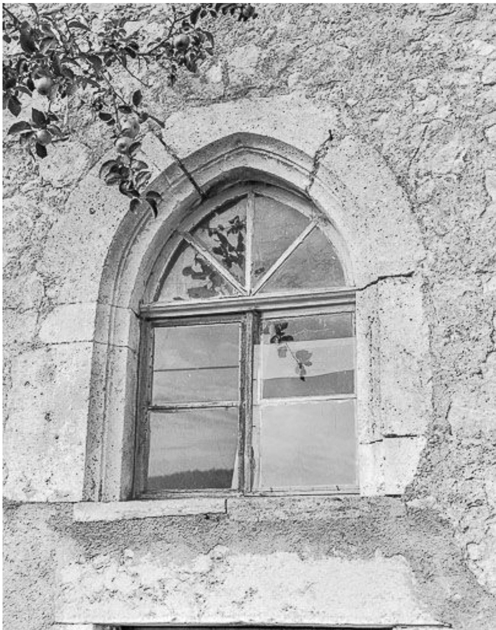
Détail de la façade sur rue : fenêtre.
