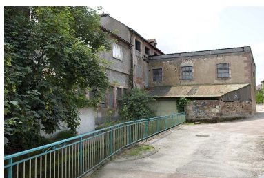
Façades postérieures donnant sur le bief.
