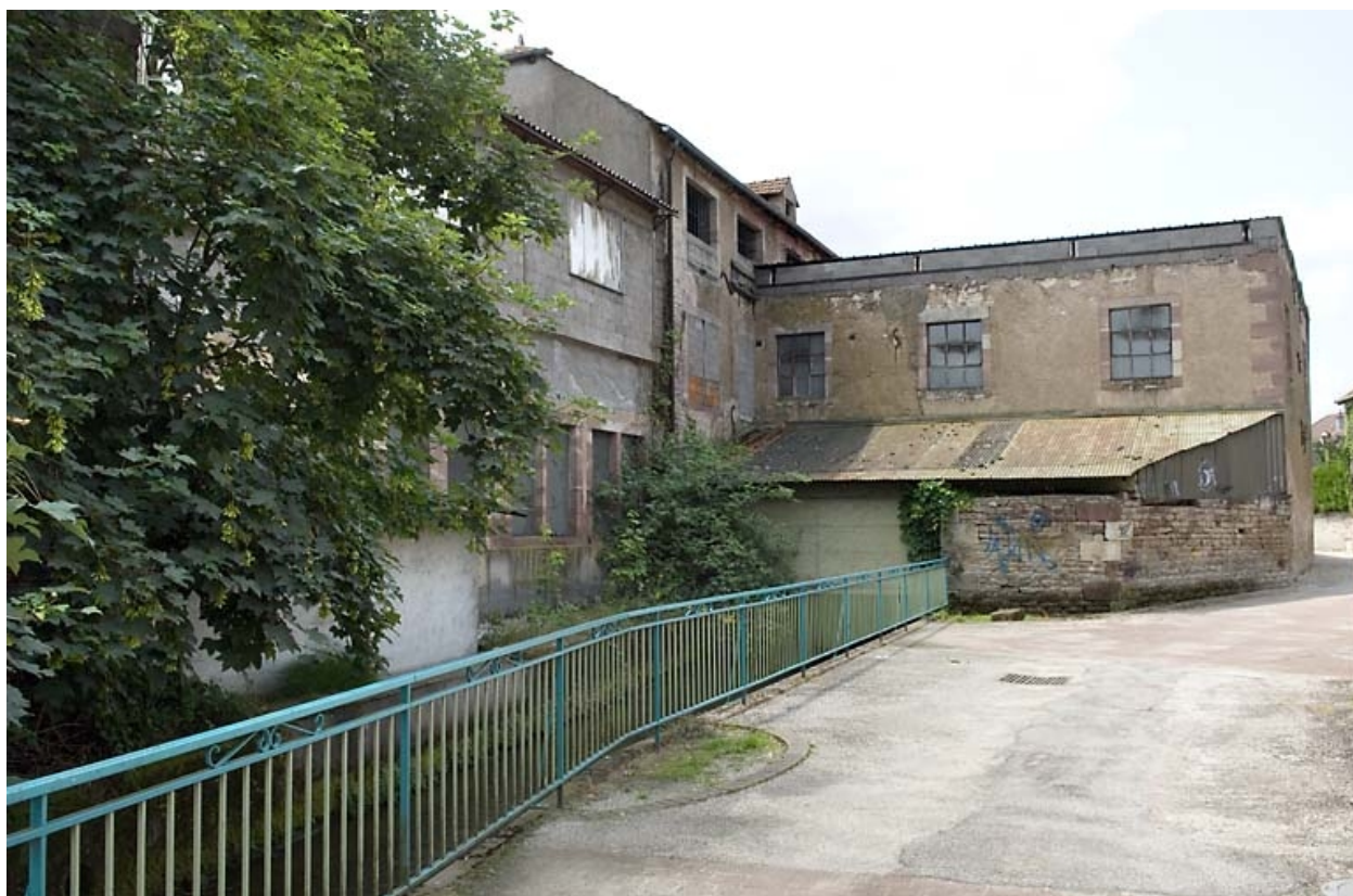
Façades postérieures donnant sur le bief.
