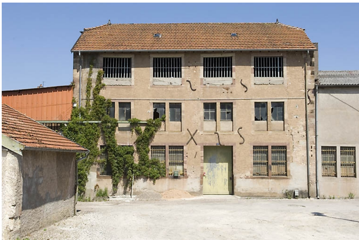
Façade sud du moulin à papier.
