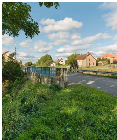
Vue du déversoir.
