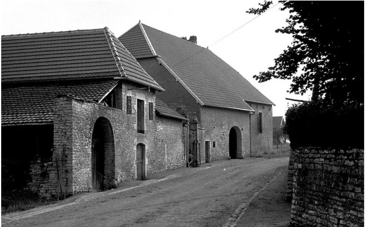
Ferme située 3 rue de Marnay.
