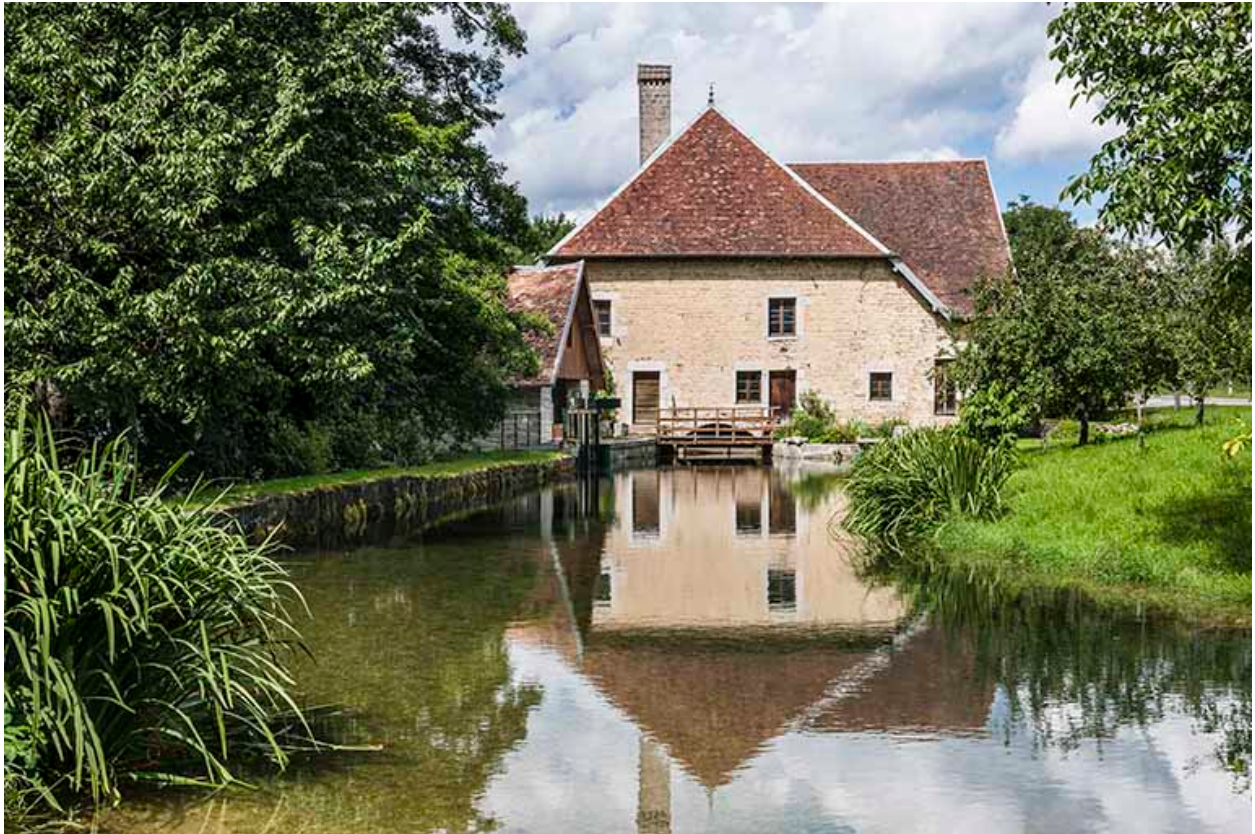
Vue d'ensemble depuis l'amont.
