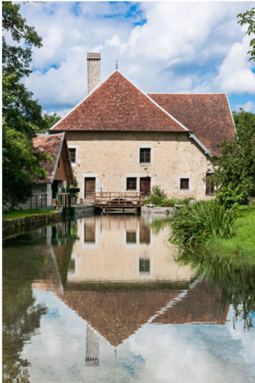
Vue d'ensemble depuis l'amont (cadrage vertical).
