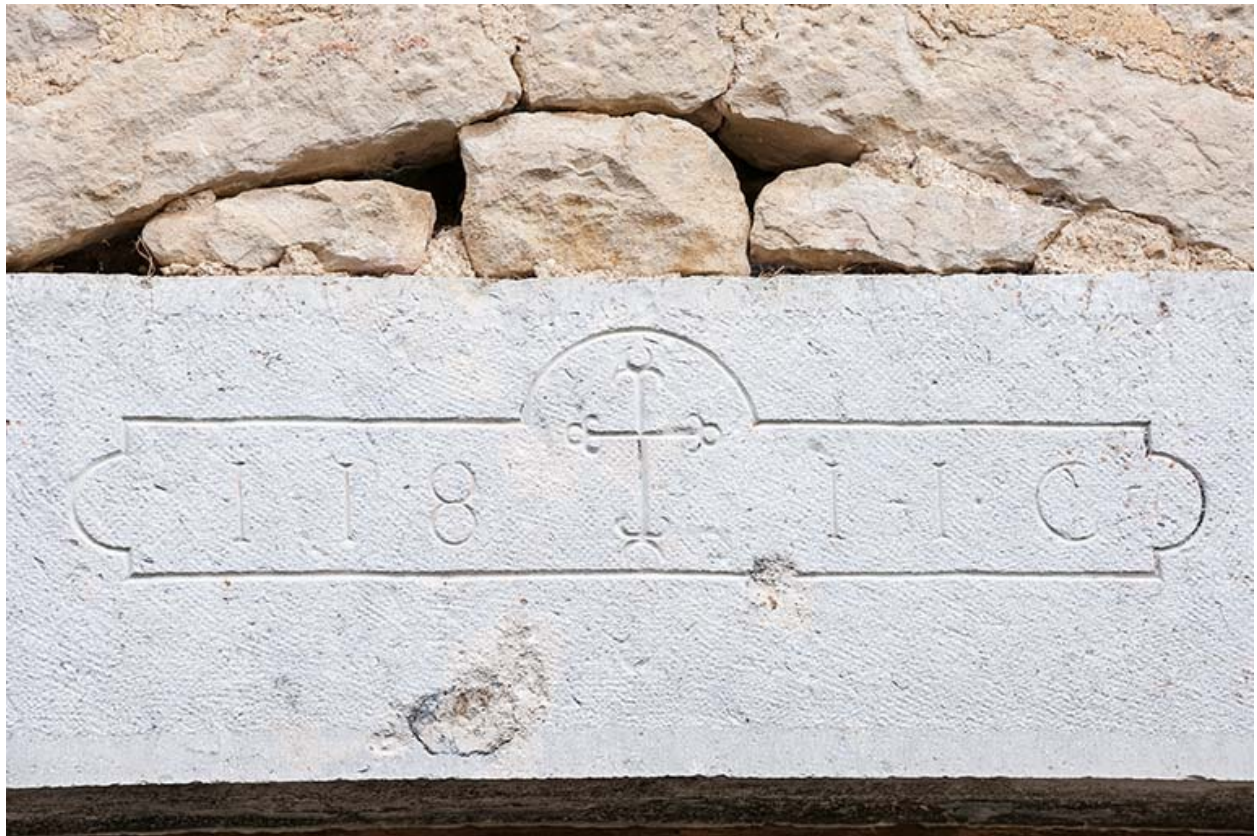
Détail d'un linteau de la façade sud.
