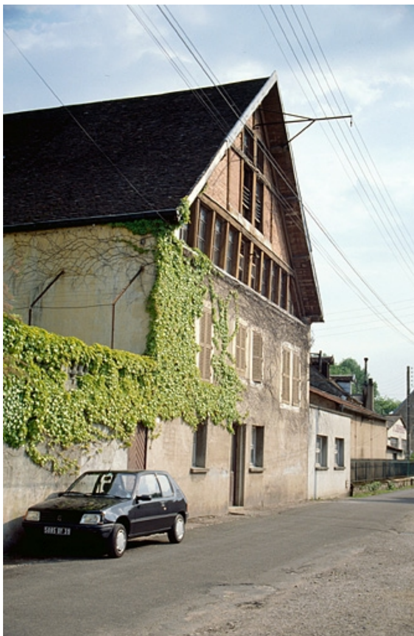
Façade antérieure de l'atelier de fabrication (J).
