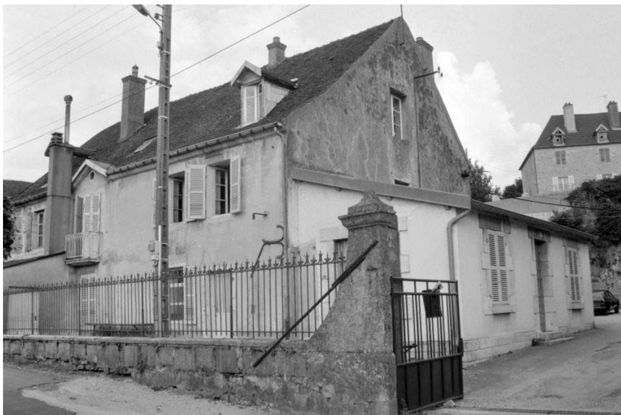
Bureau-logement patronal, vu de trois quarts droit.
