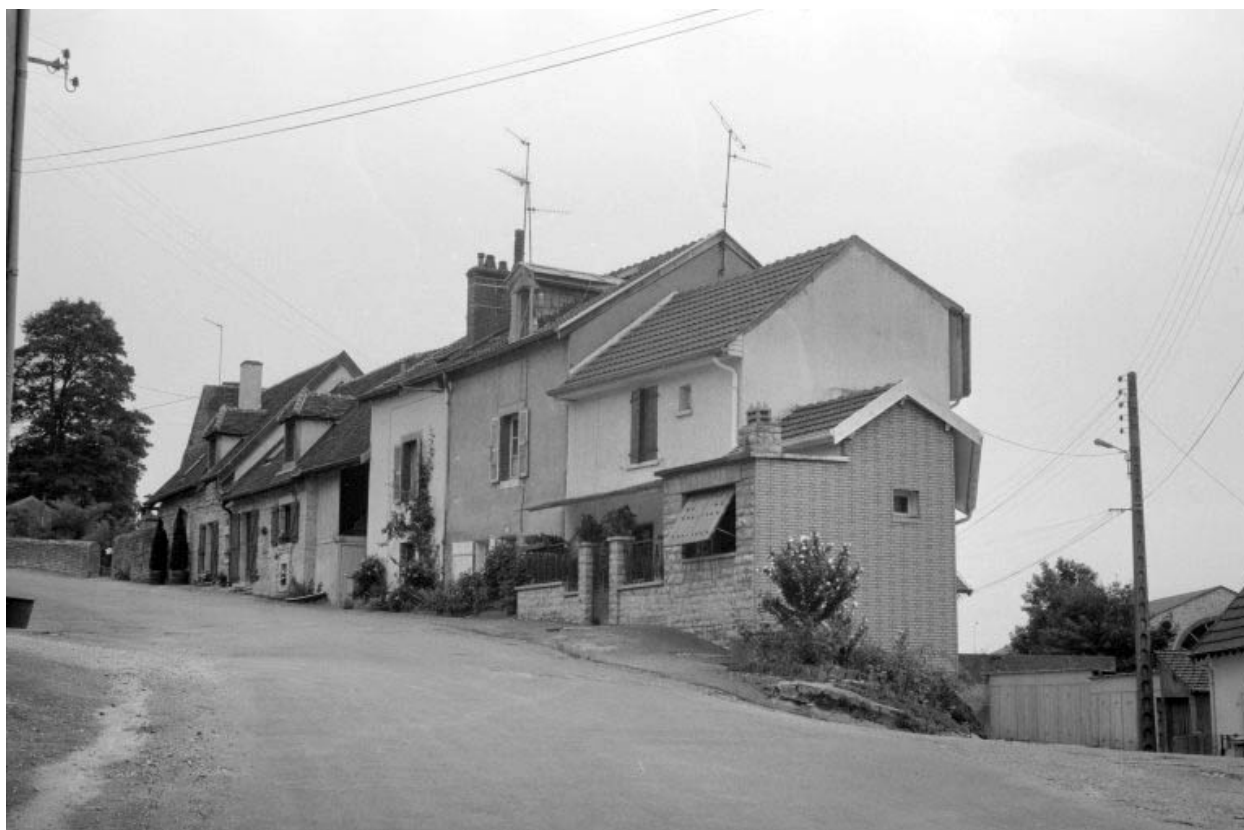
Logements d'ouvriers, depuis le nord.
