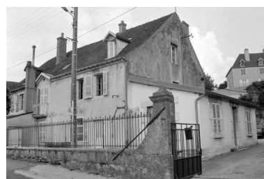
Bureau-logement patronal, vu de trois quarts droit. Phot. Laurent Poupard IVR43_19893900119Z
