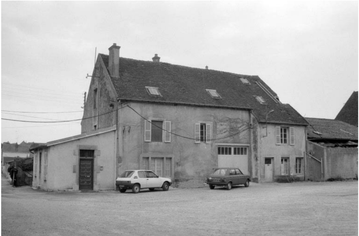
Façade postérieure du bureau-logement patronal.
