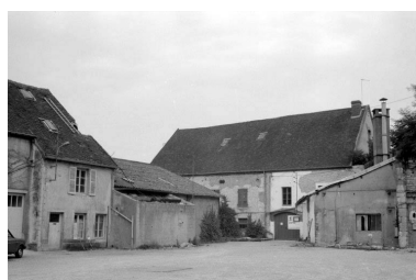
Ateliers de fabrication (H, J) et hangar. Phot. Laurent Poupard IVR43_19893900116Z
