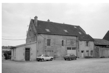
Façade postérieure du bureau-logement patronal. Phot. Laurent Poupard IVR43_19893900115Z
