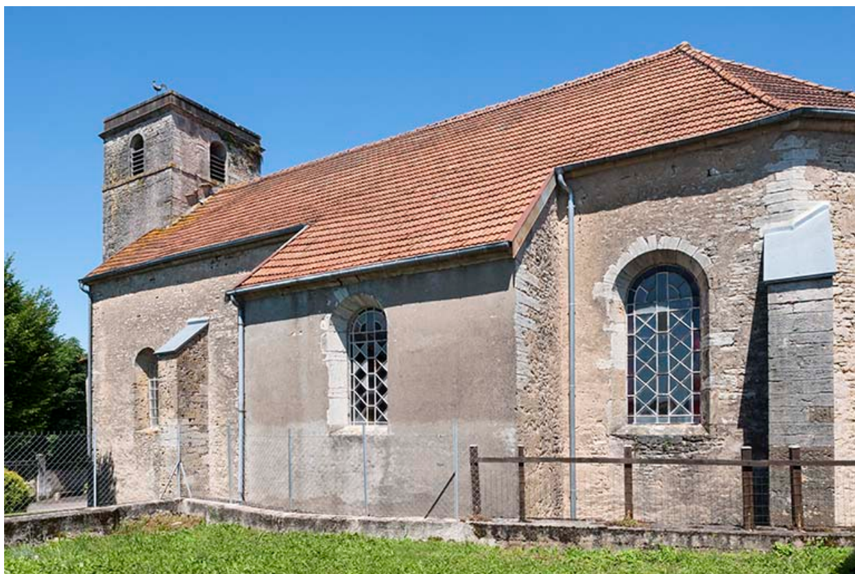
Vue latérale Sud
