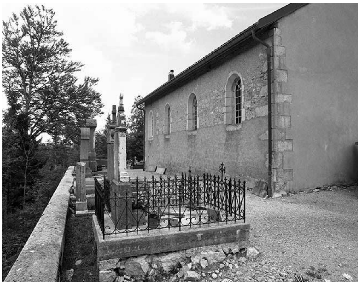
Façade gauche vue de trois quarts.
