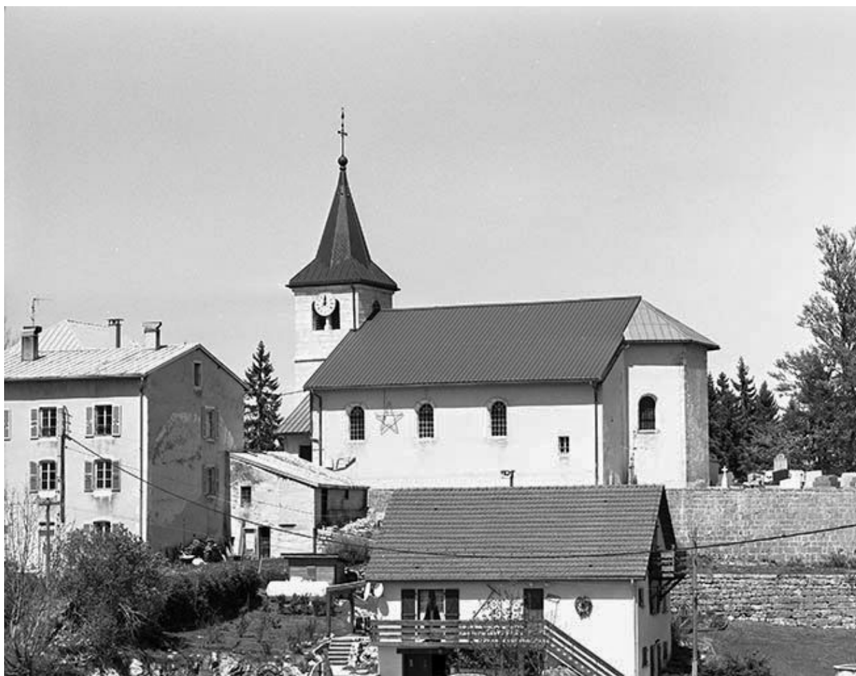
Vue éloignée de la façade latérale droite.
