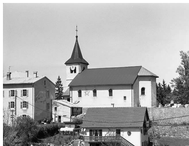
Vue éloignée de la façade latérale droite. Phot. Jérôme Mongreville IVR43_20003900617X
