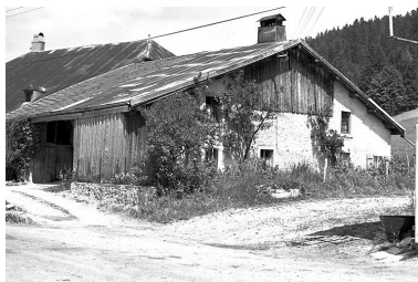
Façade sur rue et pignon d'habitation. Phot. Dominique Dominguez IVR43_19792500978X
