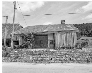
Façade sur rue. Phot. Dominique Dominguez
