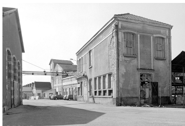
Transformateur électrique (?). Phot. Yves Sancey IVR43_20009000285X
