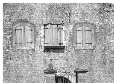
Valay, maison située rue Fénelon : exemple de mur en moellons calcaire recouverts d'enduit.
