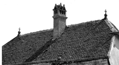
Motey-Besuche, ferme située rue du Crotot : détail du toit recouvert de tuiles plates. Phot. Bernard Lardière IVR43_19817000548Z
