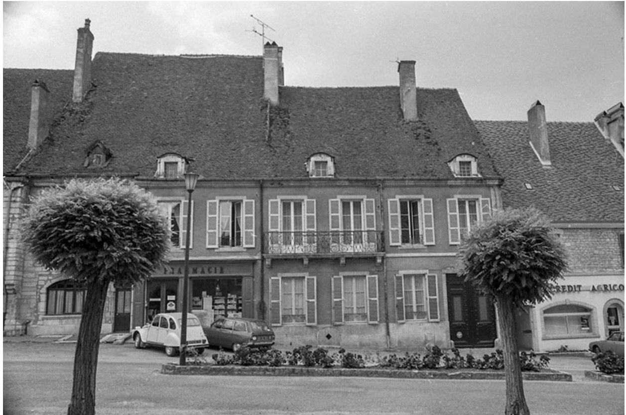
Pesmes, maison avec local commercial en rez-de-chaussée.
