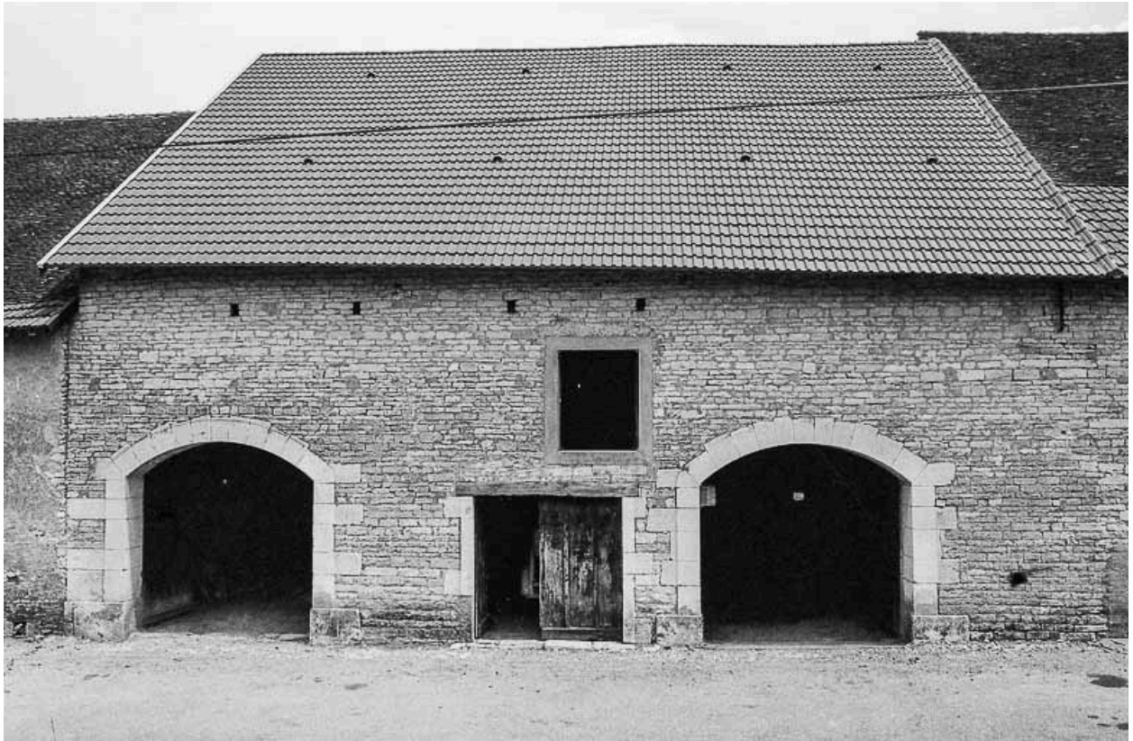
Bard-lès-Pesmes, ferme située rue du Mont : exemple de ferme à travées divisées avec parties agricoles sur la façade antérieure et l'habitation sur la façade postérieure.
