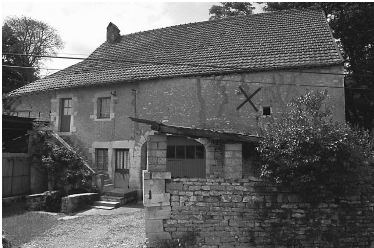
Montagney, ferme située route de Motey-Besuche.
