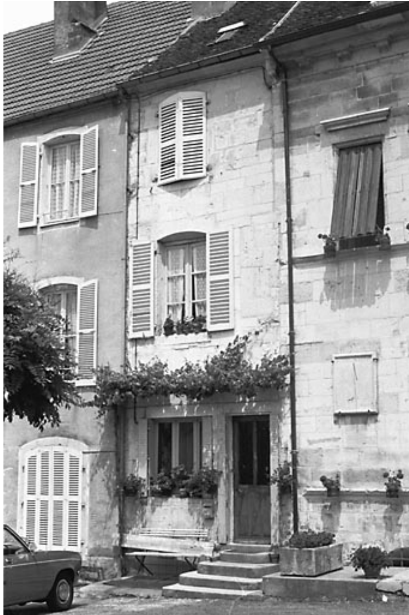
Pesmes, maison située 21 Grande-Rue : exemple de mur en pierre de taille.
