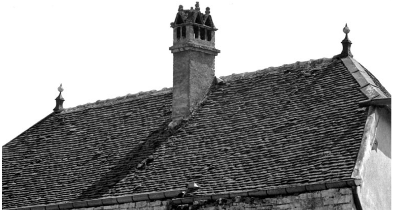
Motey-Besuche, ferme située rue du Crotot : détail du toit recouvert de tuiles plates.
