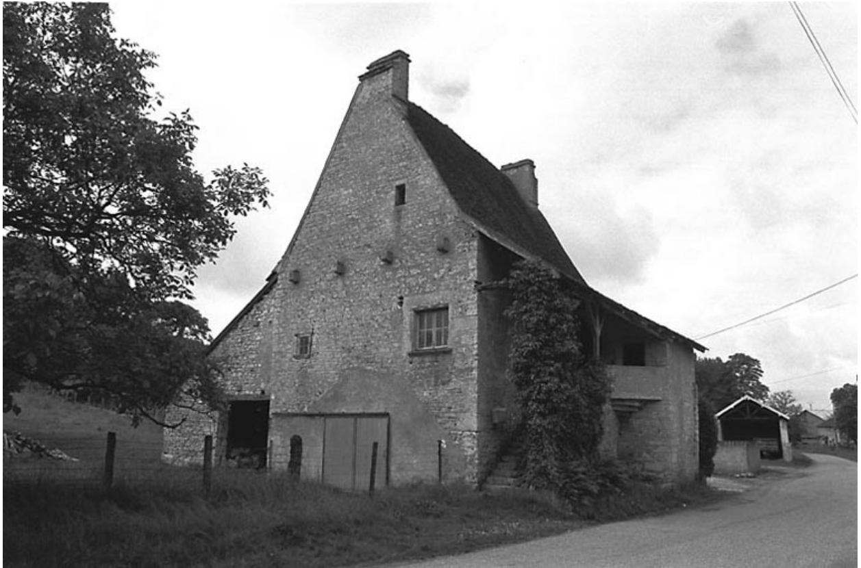
Chevigny, maison située rue de l'Eglise.
