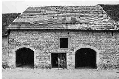
Bard-lès-Pesmes, ferme située rue du Mont : exemple de ferme à travées divisées avec parties agricoles sur la façade antérieure et l'habitation sur la façade postérieure. Phot. Bernard Lardière IVR43_19817000214Z
