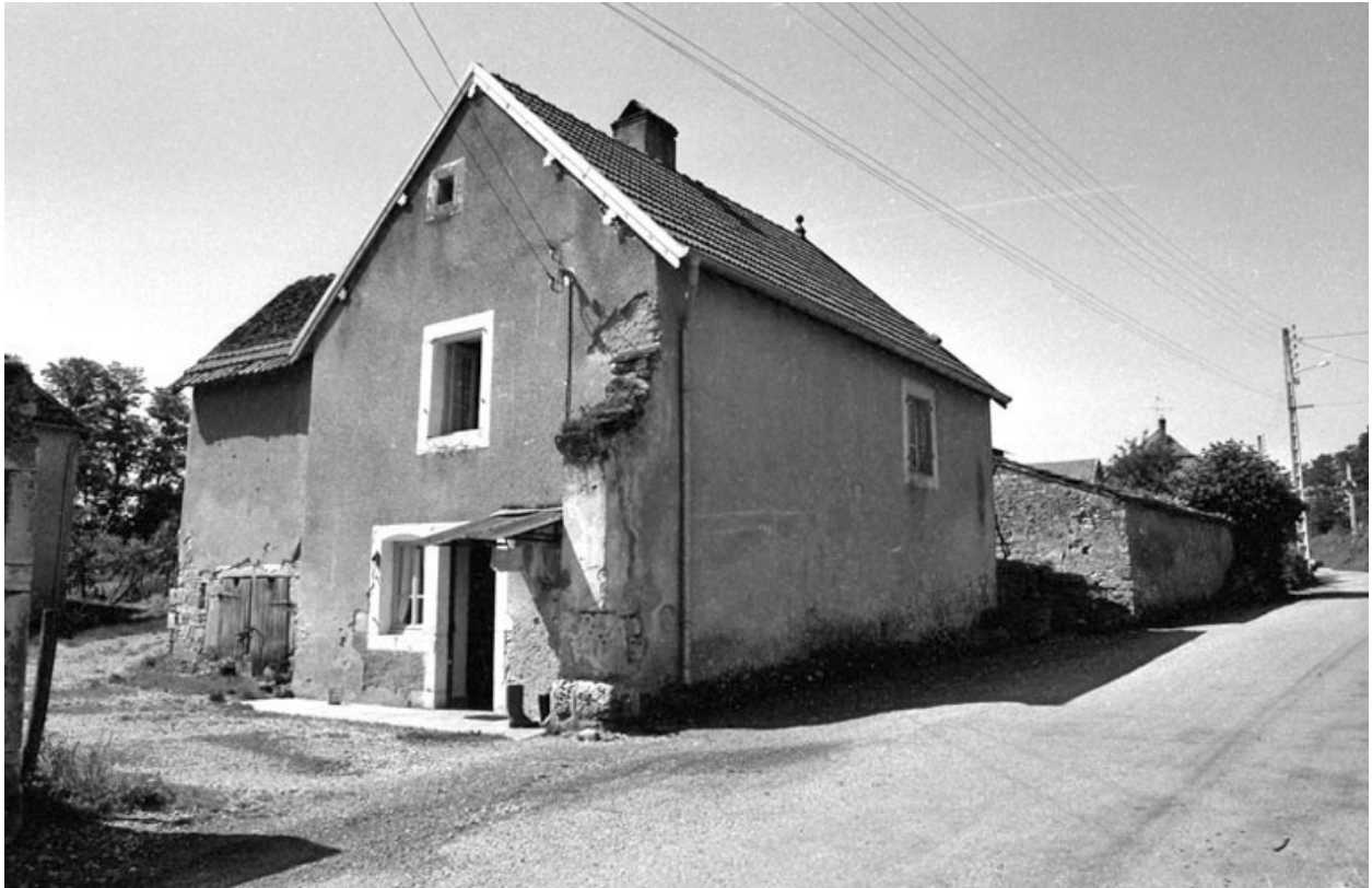
Vènère, ferme située route de Valay : exemple de ferme-bloc avec petit logement.
