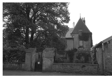
Vadans, maison située rue de Lieucourt. Phot. Bernard Lardière IVR43_19817000611Z
