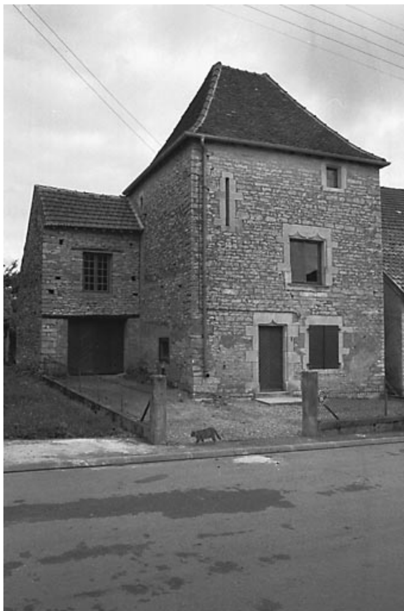
La Résie-Saint-Martin, maison située rue Haute.
