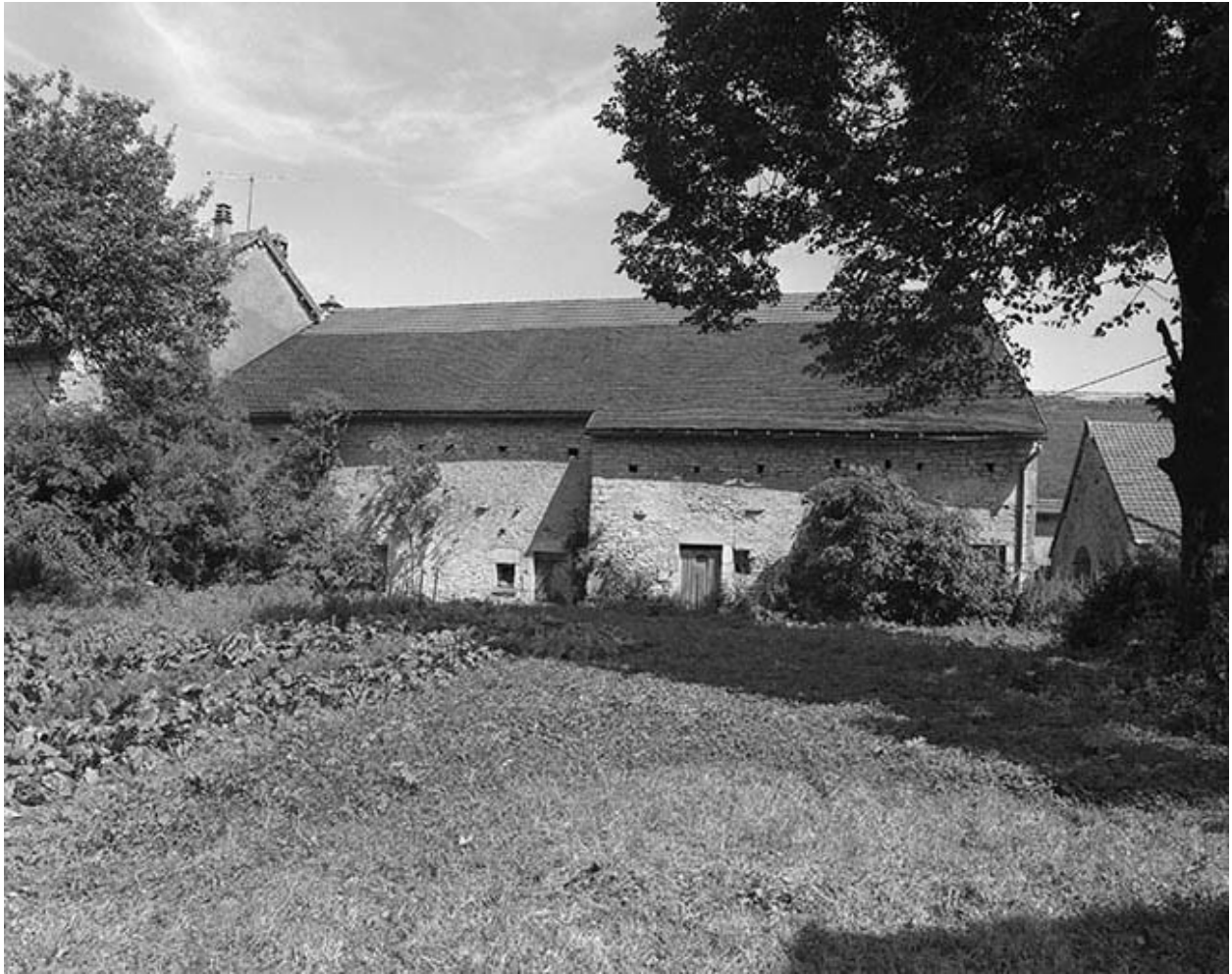
Ferme : façade postérieure.
