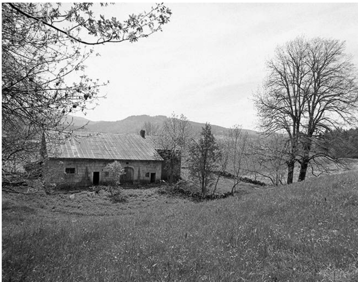
Vue éloignée de la façade postérieure.
