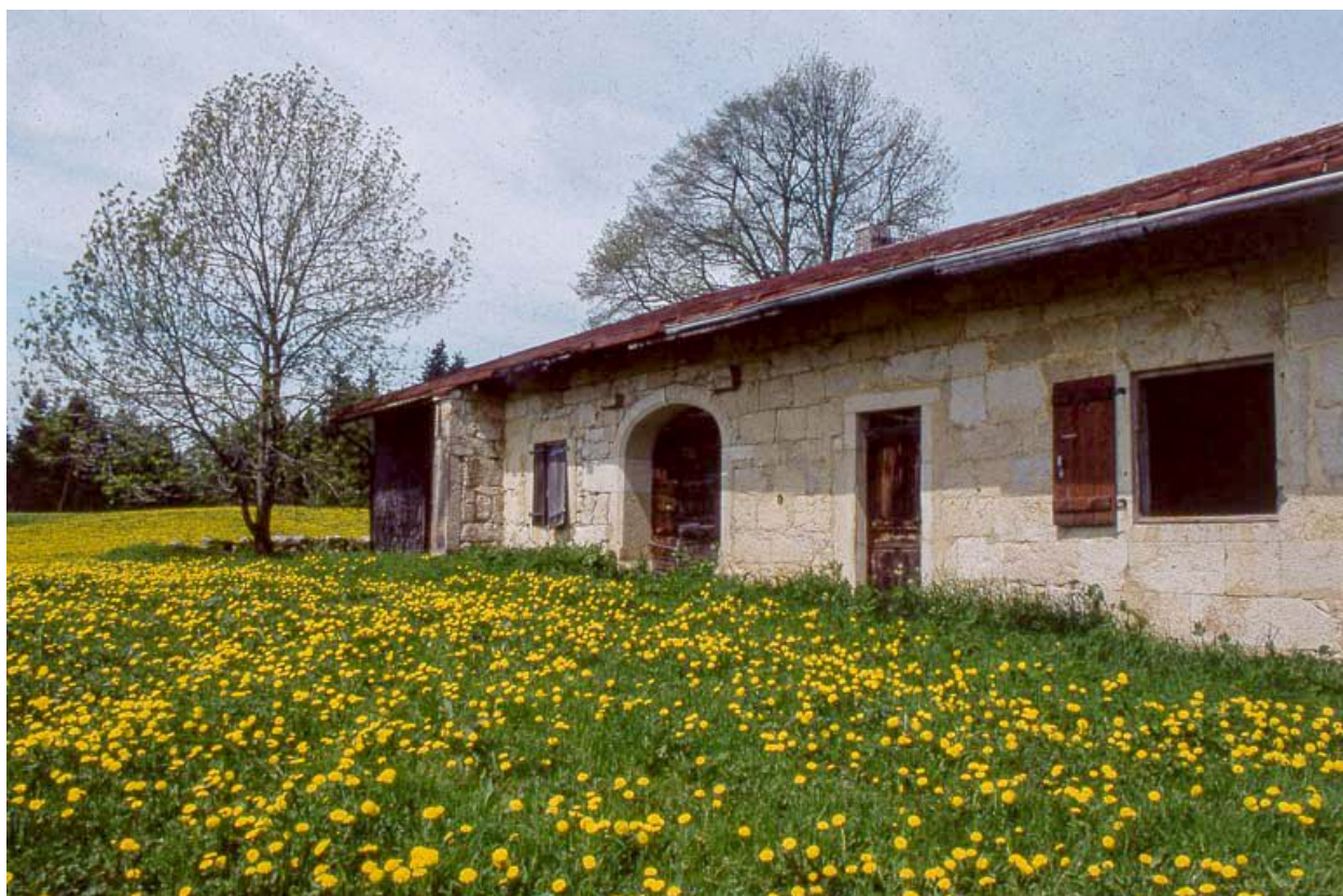
Façade antérieure, vue rapprochée.
