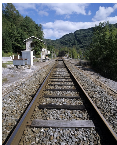
Exemple de voie avec traverses en bois. Phot. Yves Sancey IVR43_20043900380XA
