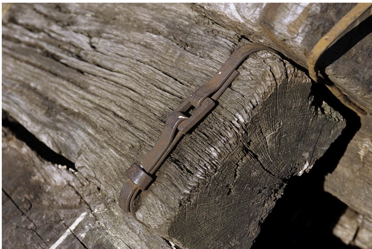
Extrémité d'une traverse avec frettage Delor.
