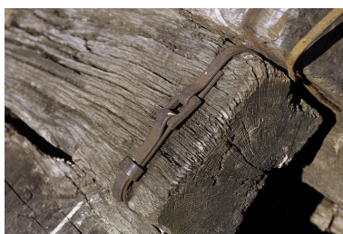
Extrémité d'une traverse avec frettage Delor. Phot. Yves Sancey IVR43_20043900447ZA
