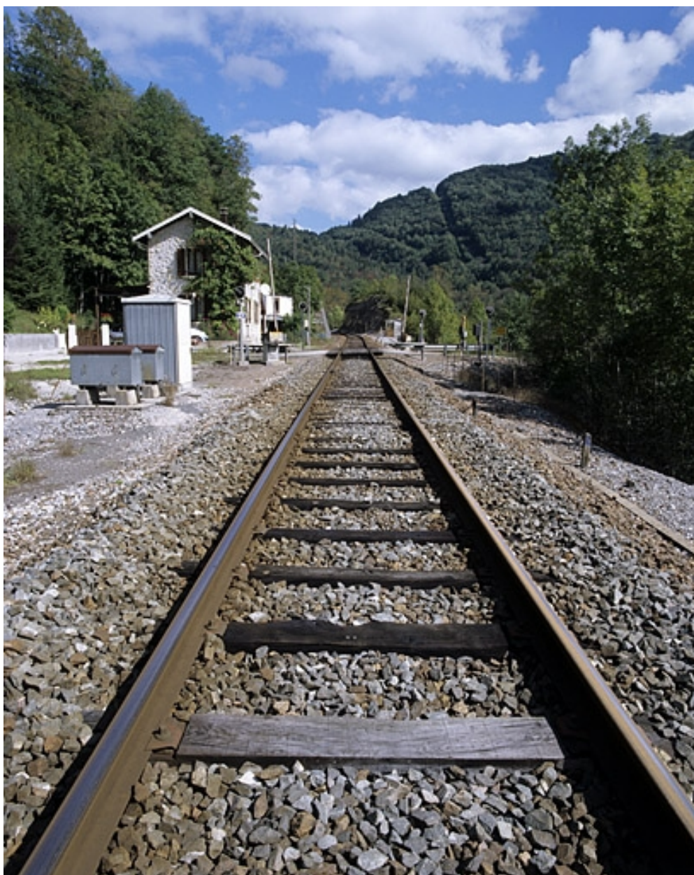
Exemple de voie avec traverses en bois.
