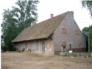
Vue d'ensemble de la façade de 3/4 droit. Phot. Gaëlle Prost IVR26_20057102534NUCA
