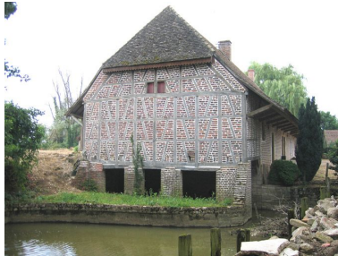
Vue d'ensemble de 3/4 gauche. Phot. Gaëlle Prost IVR26_20057102535NUCA
