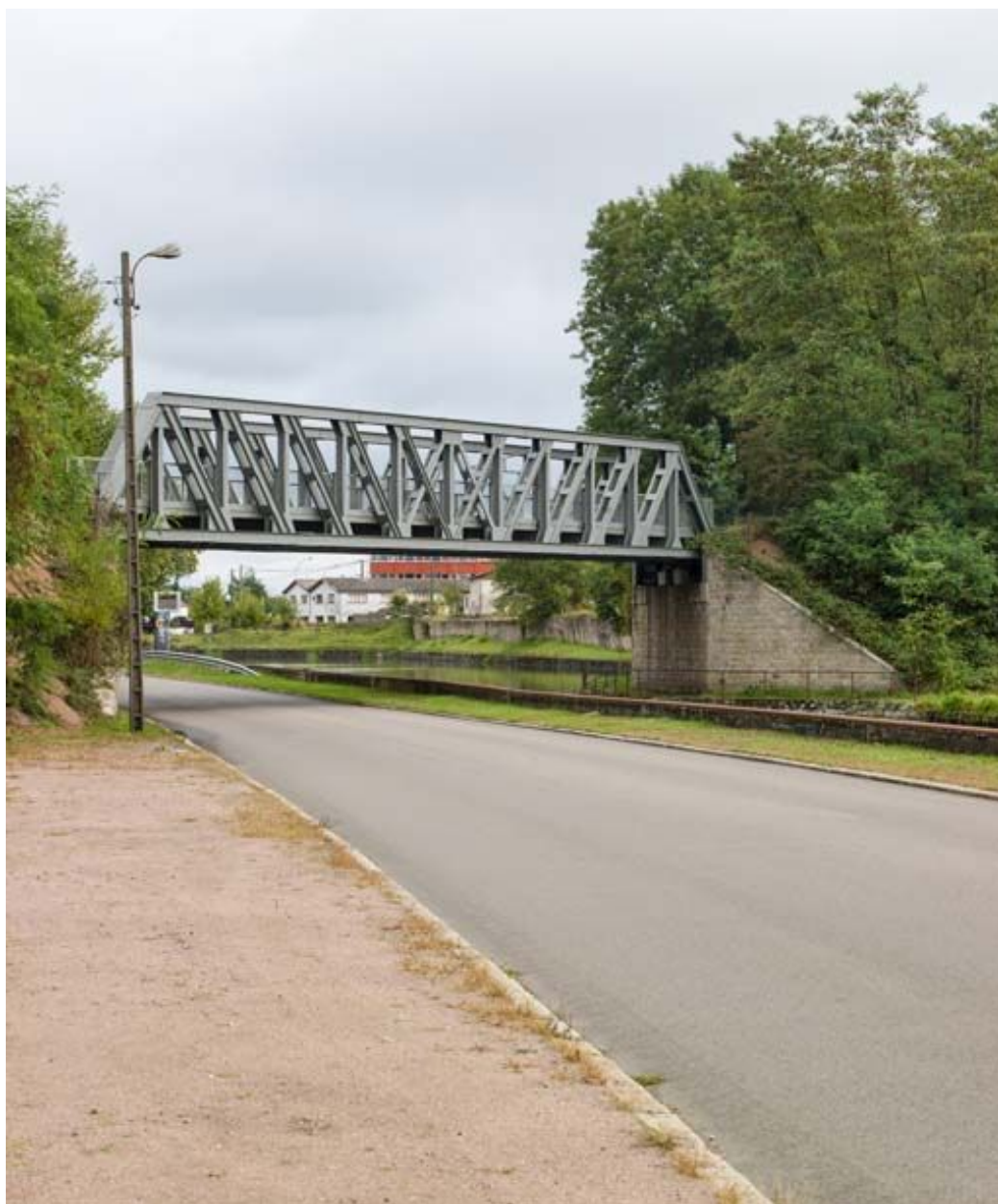
Vue d'ensemble du pont.
