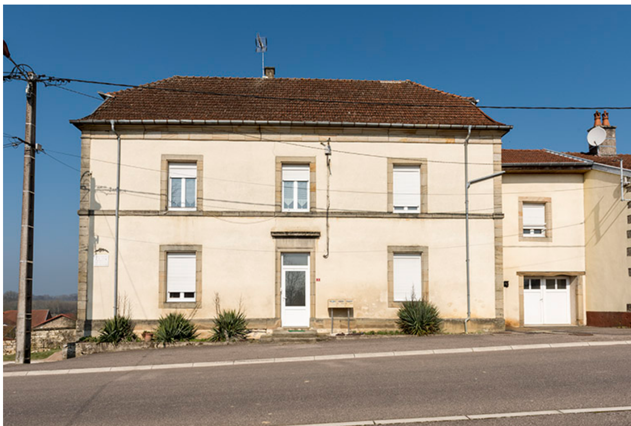
Maison d'école. Vue de face.
