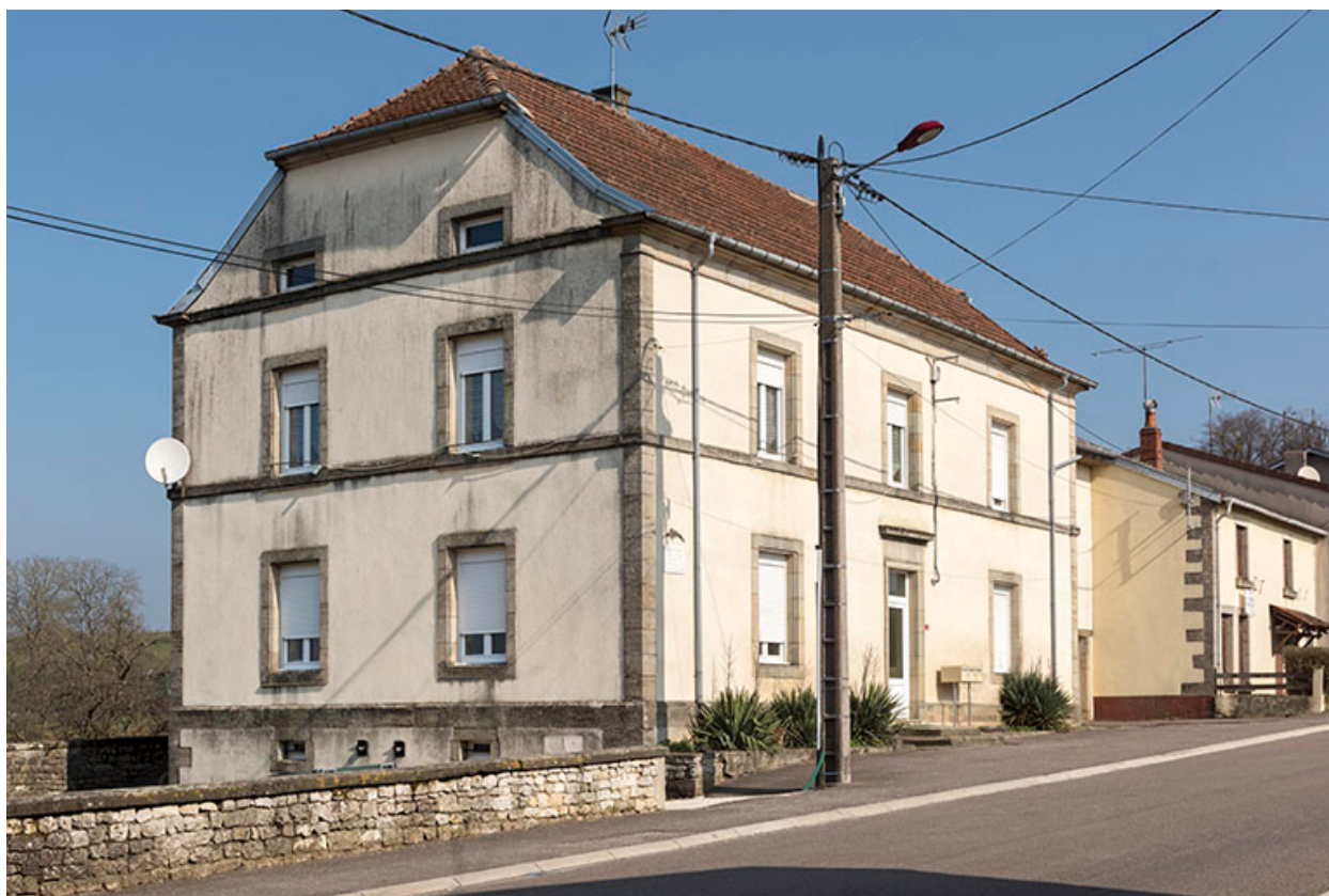
Maison d'école. Vue de trois-quart sud-ouest.
