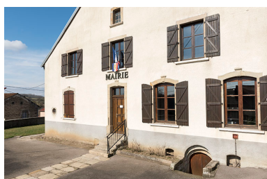
Mairie vue de trois- quart de la face antérieure. Phot. Sonia Dourlot IVR43_20177000068NUC4A
