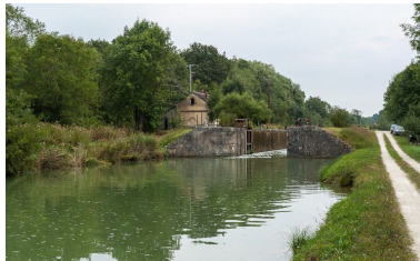
Le site d'écluse vu d'aval. Phot. Pierre-Marie Barbe-Richaud IVR26_20128900562NUC4AQ
