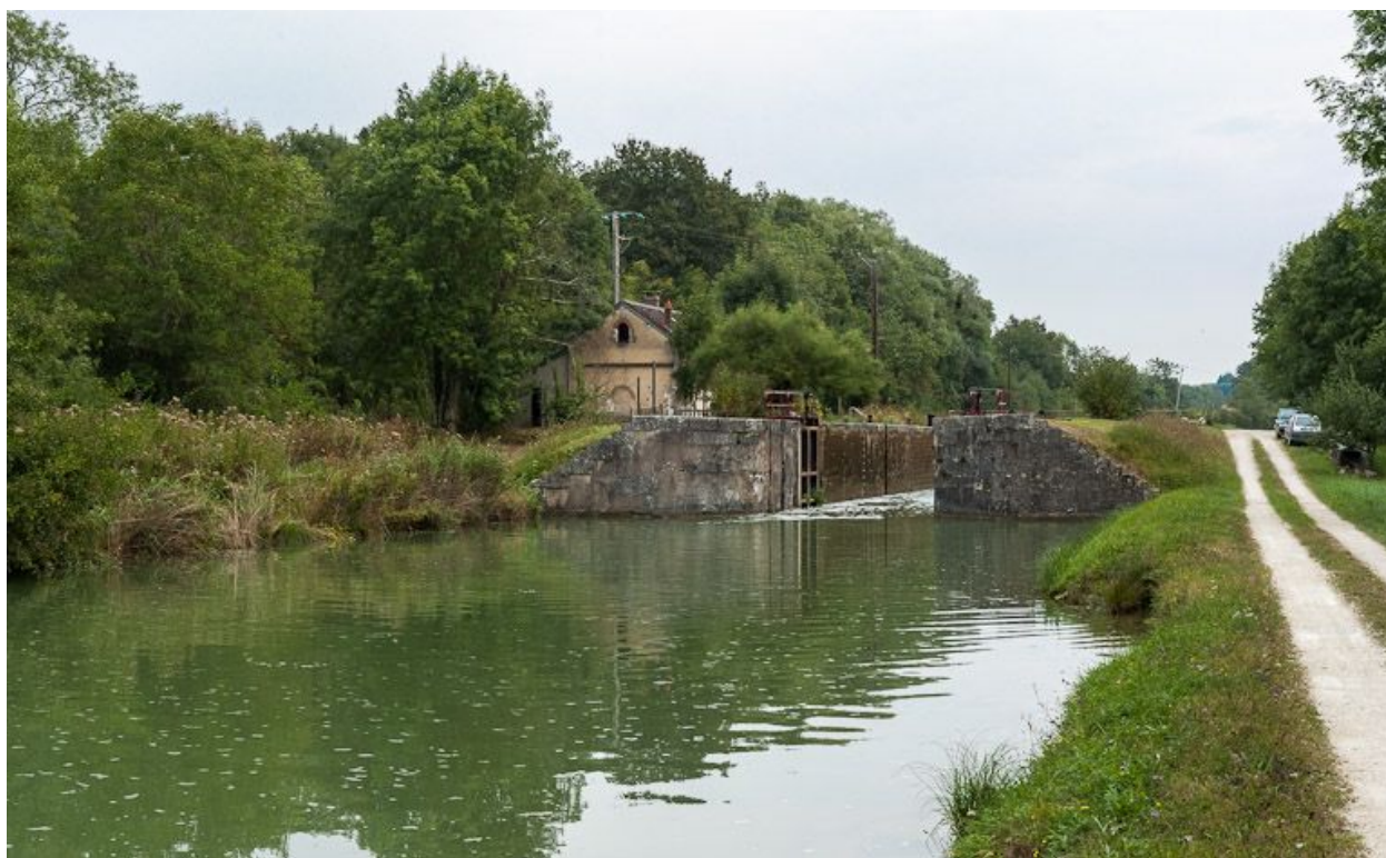
Le site d'écluse vu d'aval.
