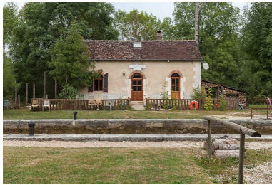
Maison éclusière de face. Phot. Pierre-Marie Barbe-Richaud IVR26_20128900561NUC4AQ
