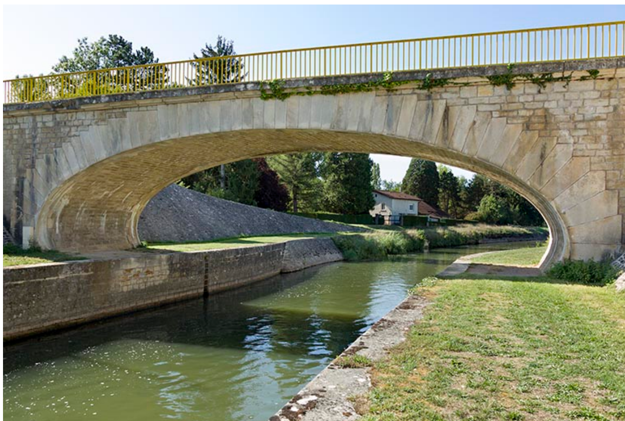
Le pont et son arc en forme d'ellipse.
