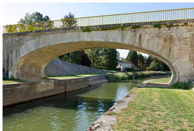
Le pont et son arc en forme d'ellipse. Phot. Sonia Dourlot IVR43_20167001783NUC2A
