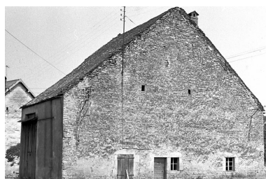
Ferme située Grande Rue (détruite après 1976). Phot. Liliane Hamelin IVR43_19762500881Z
