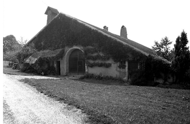
Ferme située au lieudit Bois-Vieille. Phot. Liliane Hamelin IVR43_19762500860Z
