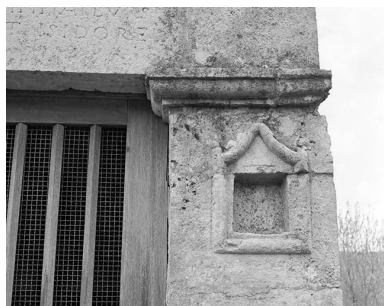
La niche du piédroit de la porte. Phot. Yves Sancey IVR43_19993900244X
