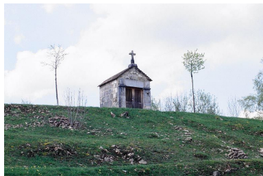
Vue générale. Phot. Yves Sancey IVR43_19993900239ZA
