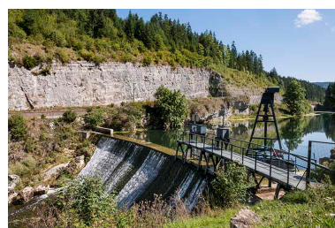
Le barrage depuis la rive gauche. Phot. Jérôme Mongreville IVR43_20152501758NUC4A
