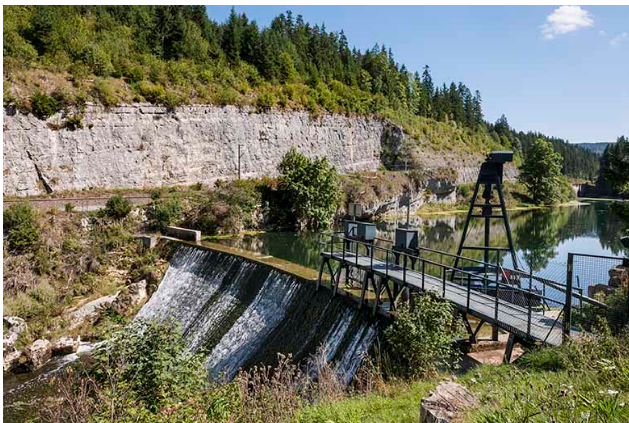
Le barrage depuis la rive gauche.
