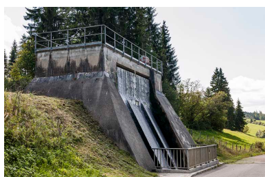
La chambre d'équilibre à l'aplomb de la centrale. Phot. Jérôme Mongreville IVR43_20152501760NUC4A
