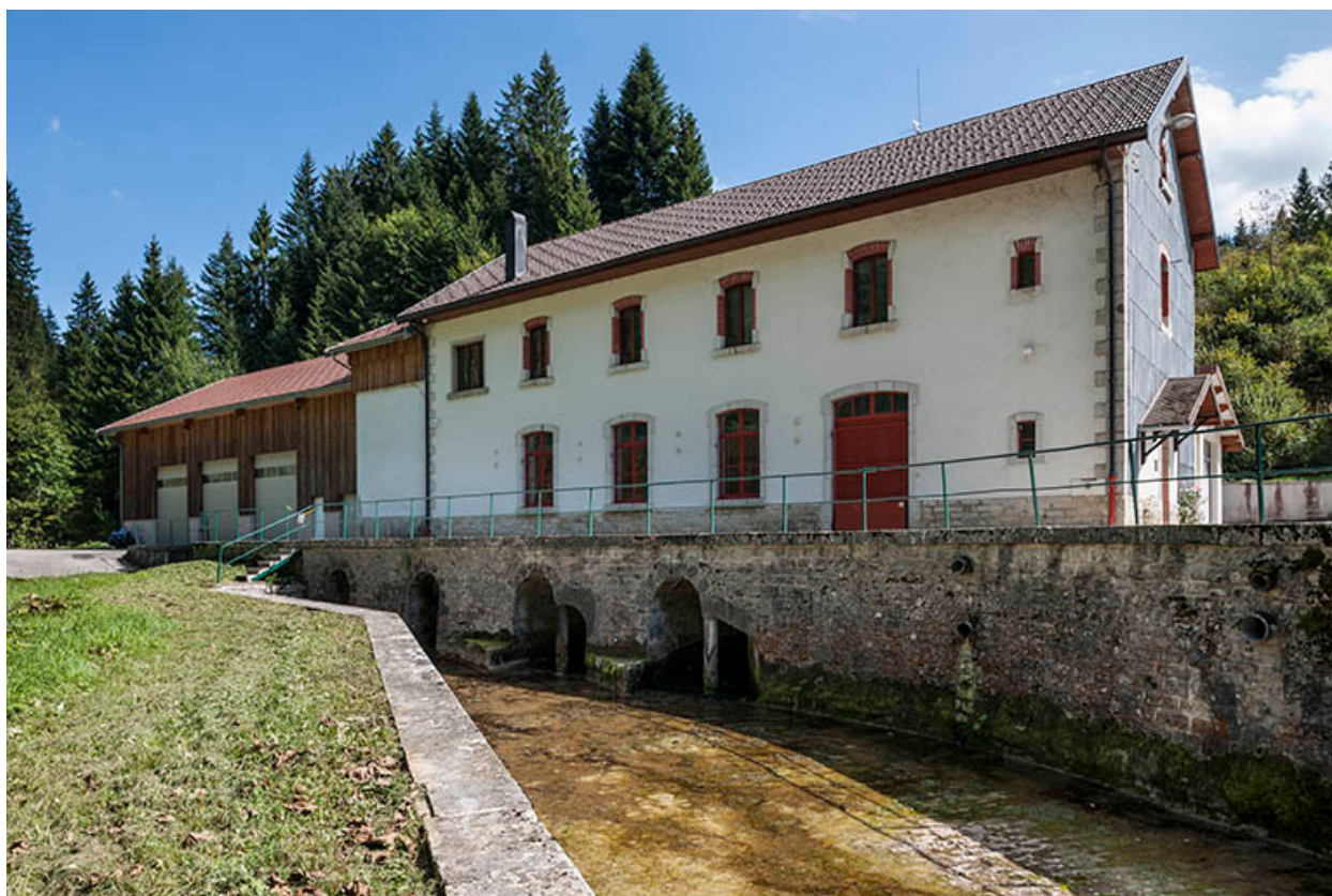
La centrale et le canal de fuite.
