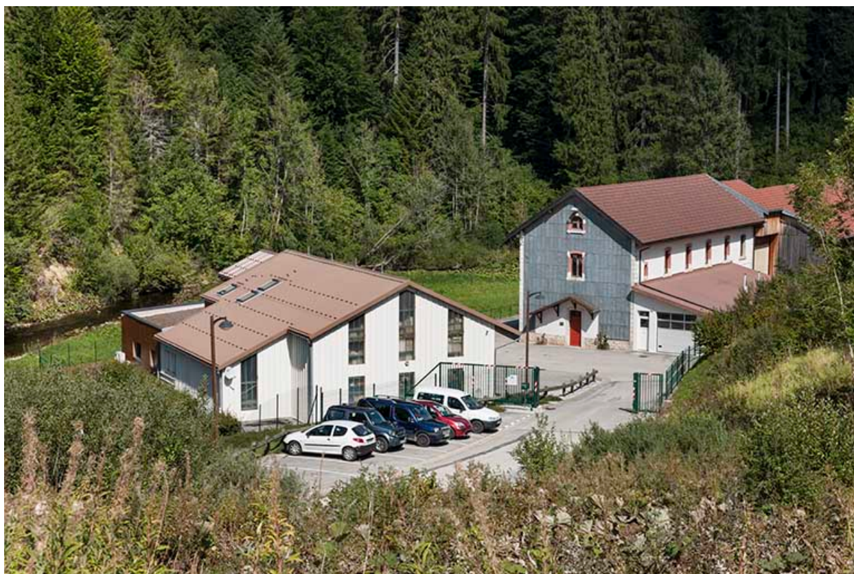
Vue rapprochée depuis le sud-ouest.
