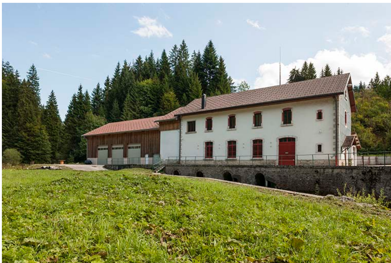
Façade nord vue de trois quarts.
