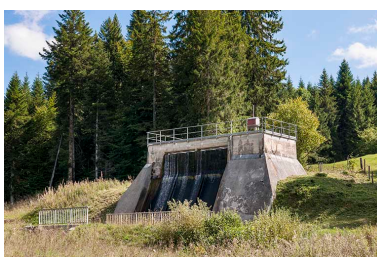
La chambre d'équilibre vue de trois quarts. Phot. Jérôme Mongreville IVR43_20152501761NUC4A
