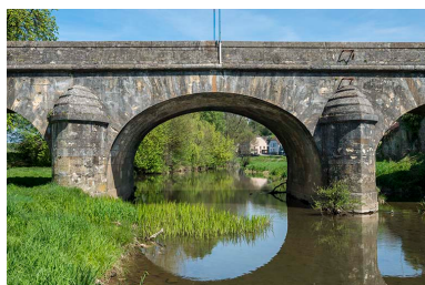
Détail de l'arche centrale. Phot. Jérôme Mongreville IVR43_20177000707NUC4A
