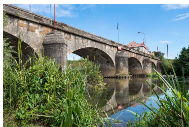
Le pont et la Saône. Phot. Jérôme Mongreville IVR43_20177001051NUC4A
