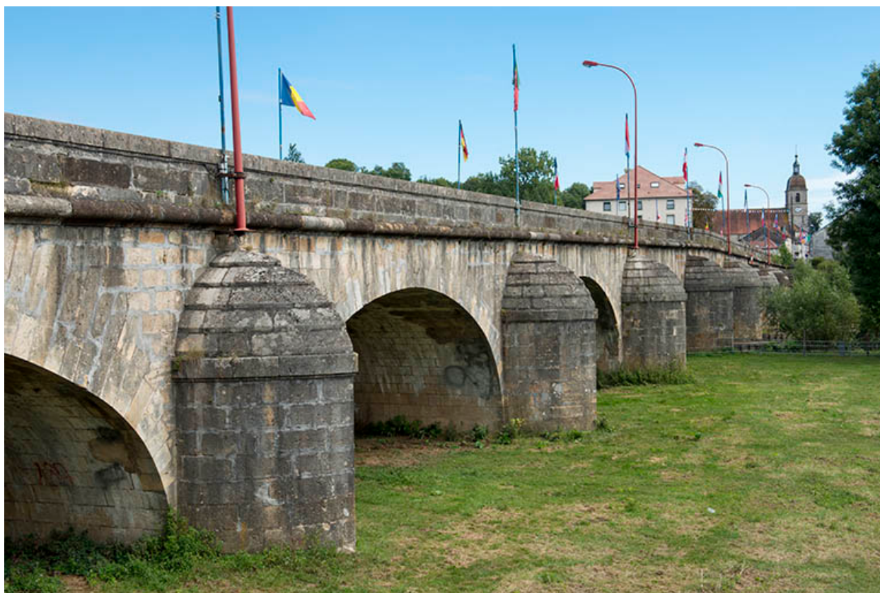
Le pont au niveau de Saint-Valère.
