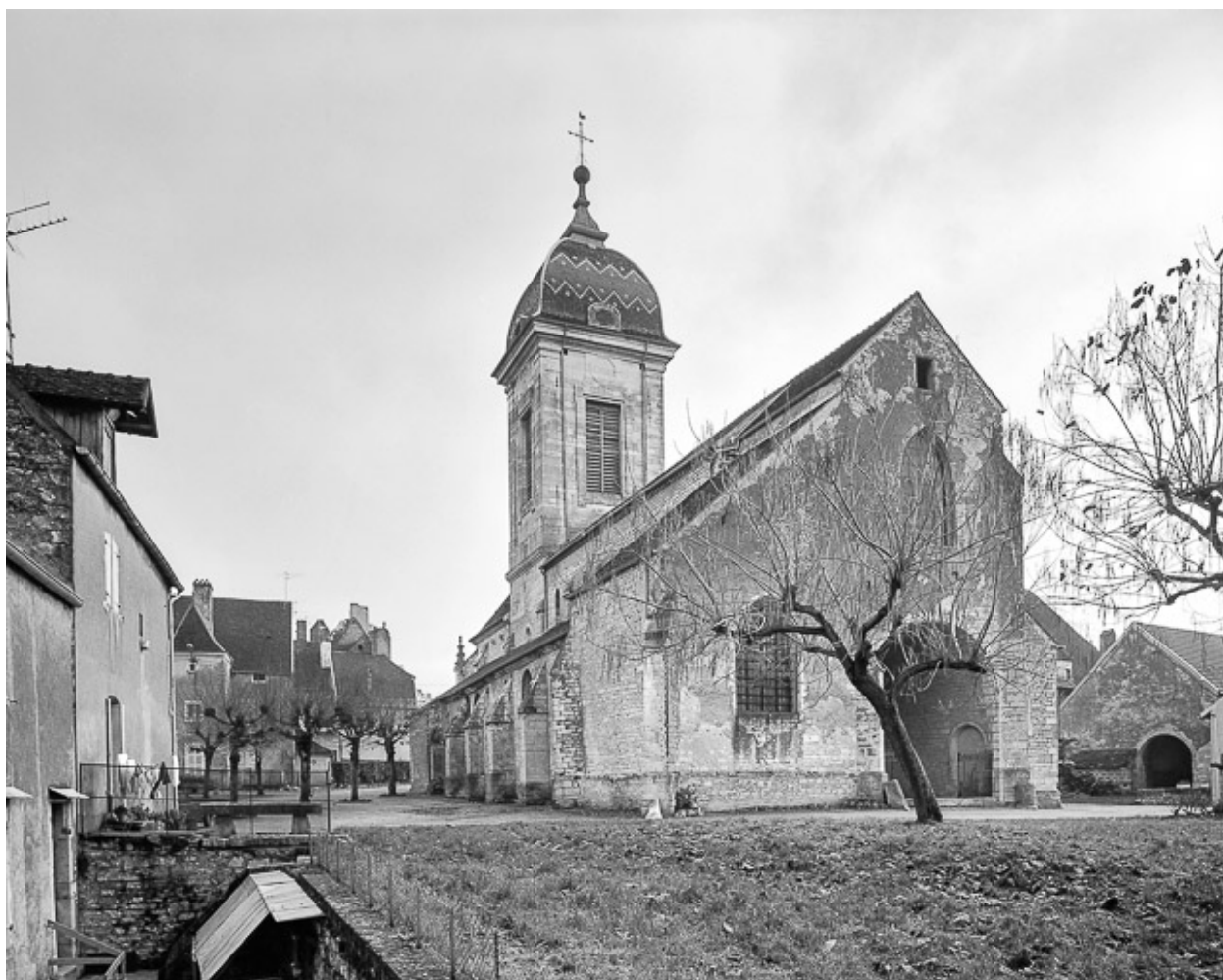
Exérieur : façade ouest.
