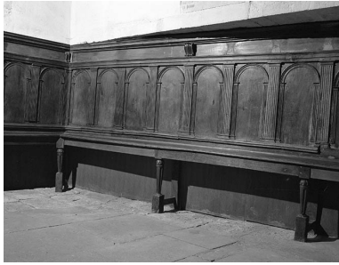
Intérieur : boiseries de la chapelle du baptistère. Phot. Yves Sancey IVR43_19827000235X
