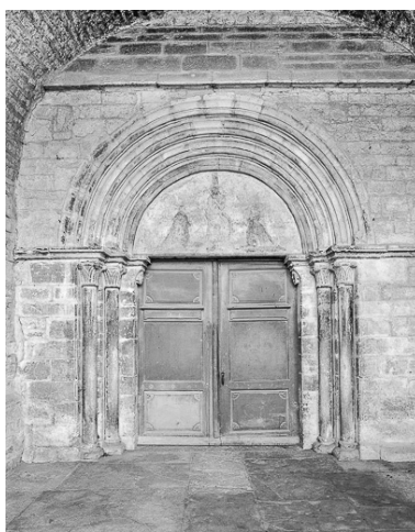
Extérieur : portail ouest. Phot. Yves Sancey IVR43_19847000073V
