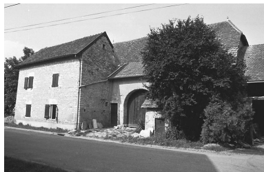
Façade sur rue. Phot. Bernard Lardière IVR43_19797000324Z
