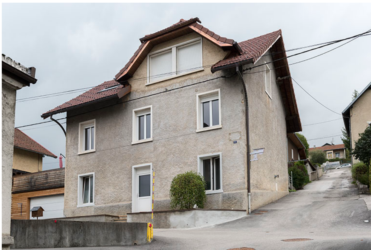
Façades antérieure et latérale droite.
