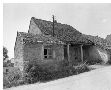
Façade antérieure en 1981. Phot. Yves Sancey IVR43_19813900162X
