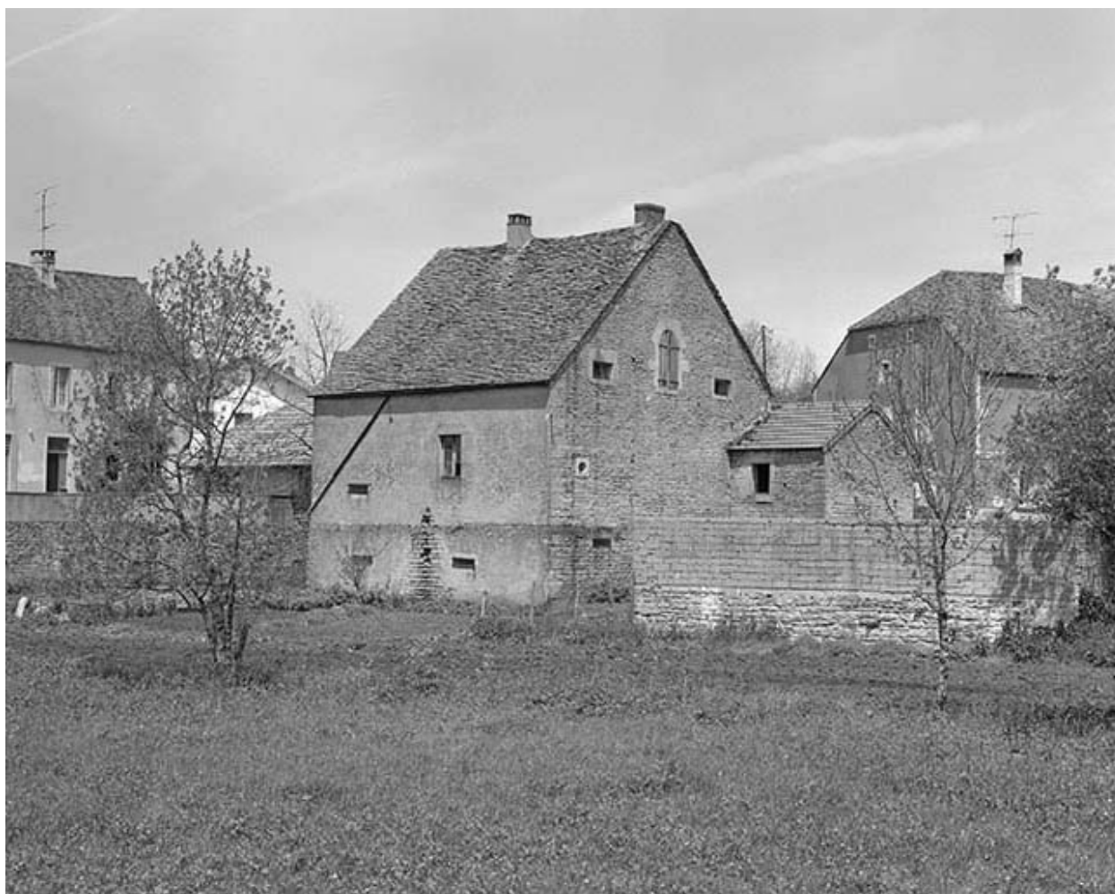
Façade postérieure et façade gauche en 1981.
