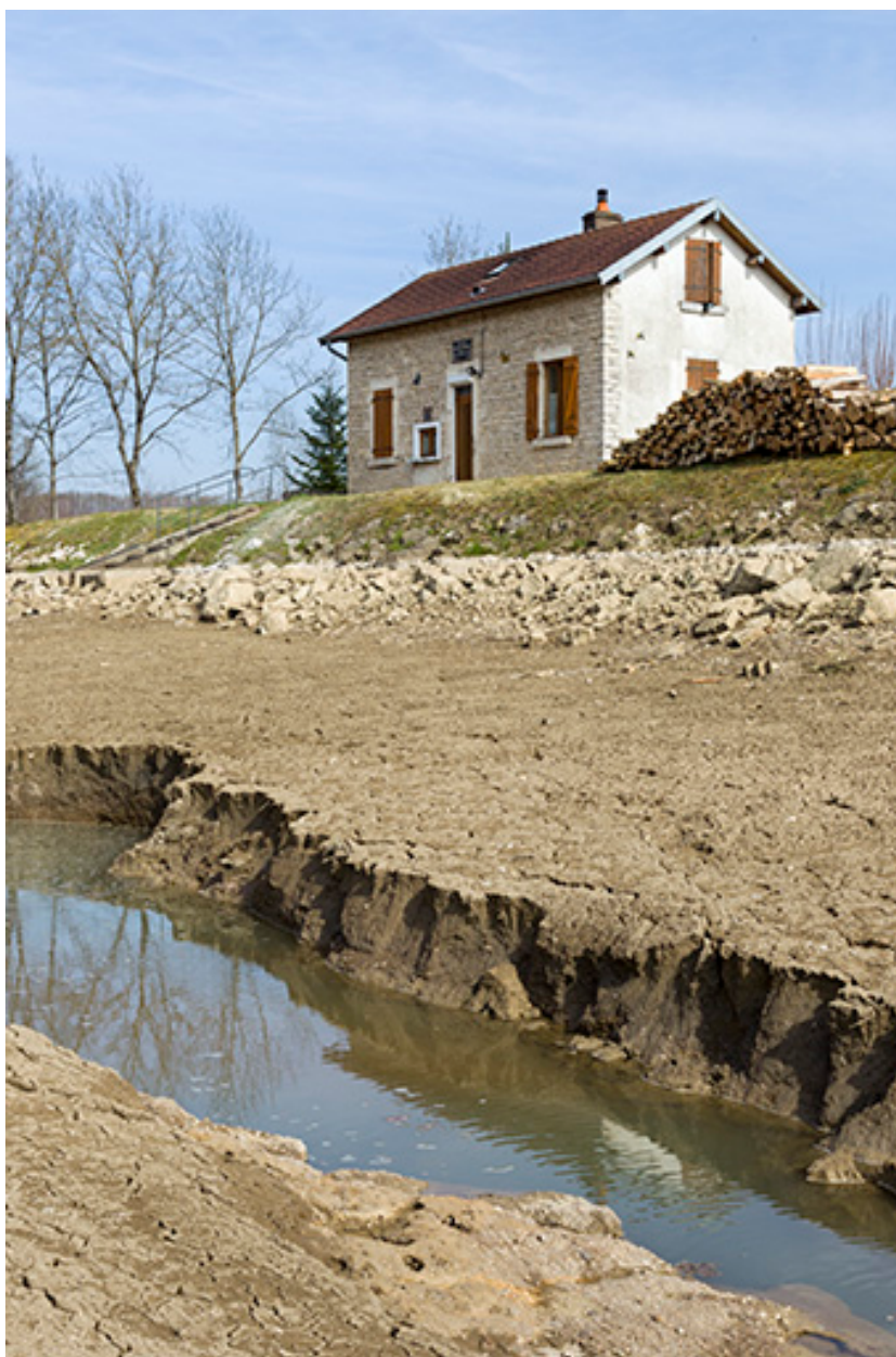
Le chenal de navigation mis hors d'eau.
