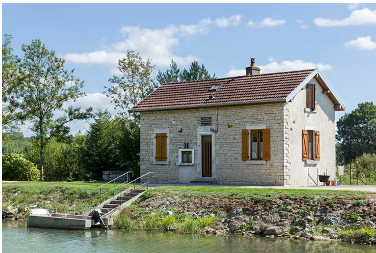
La maison de l'éclusier.
