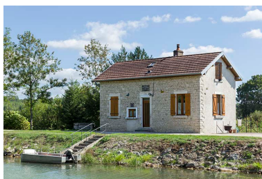
La maison de l'éclusier.
