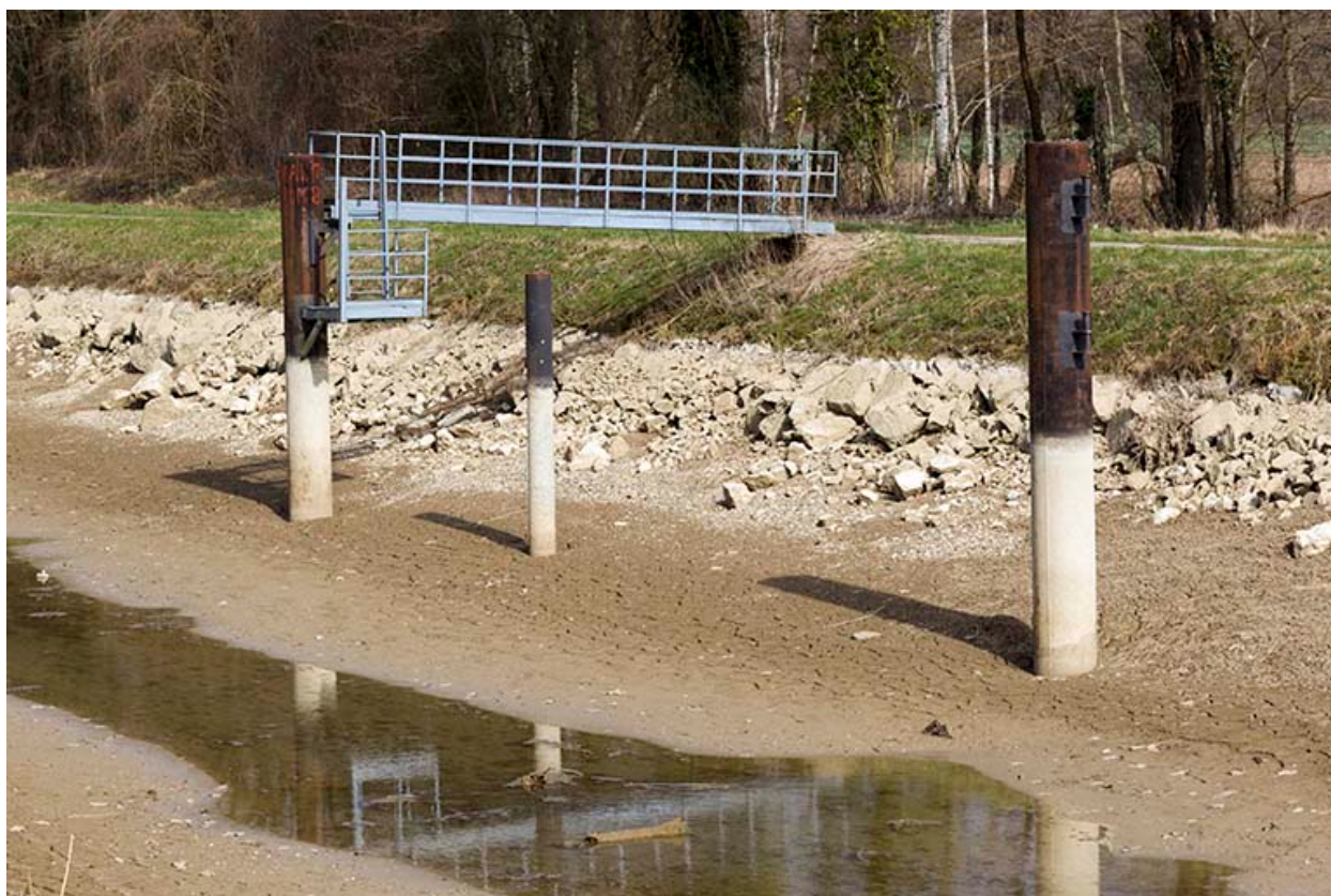
Curage du canal de navigation.
