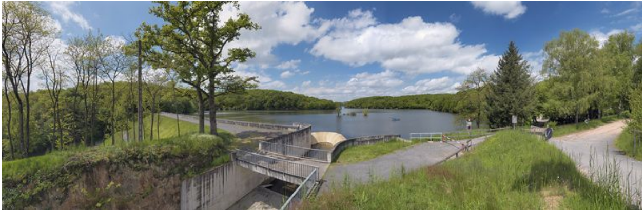
Vue d'ensemble du réservoir.
