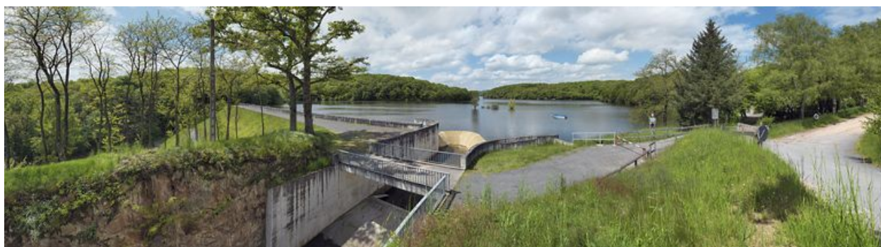
Vue d'ensemble du réservoir.
