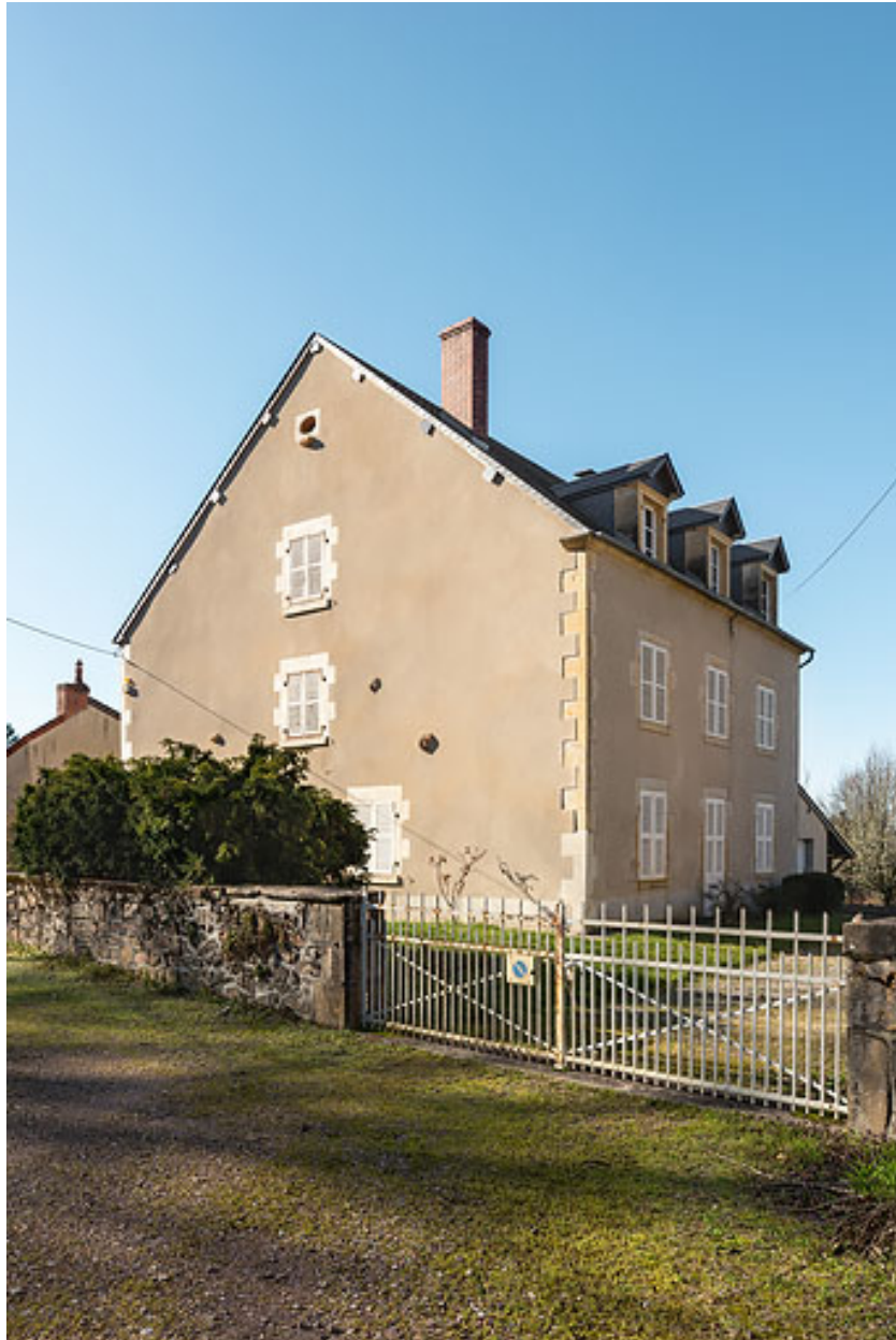
Maison (16 avenue de Rémilly) antérieure au développement du quartier thermal.
