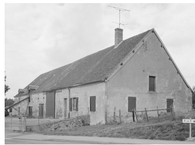
Ferme (28 avenue Eugène Collin) antérieure au développement du quartier thermal. Phot. Michel Rosso IVR26_19785800227V
