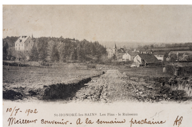
Vue du quartier thermal depuis le nord-est, avec la Villa La Rouveyre (à gauche) et l'Hôtel du Parc (au centre). Autr. auteur inconnu, Phot. Pierre-Marie Barbe-Richaud IVR26_20195800429NUC4A
