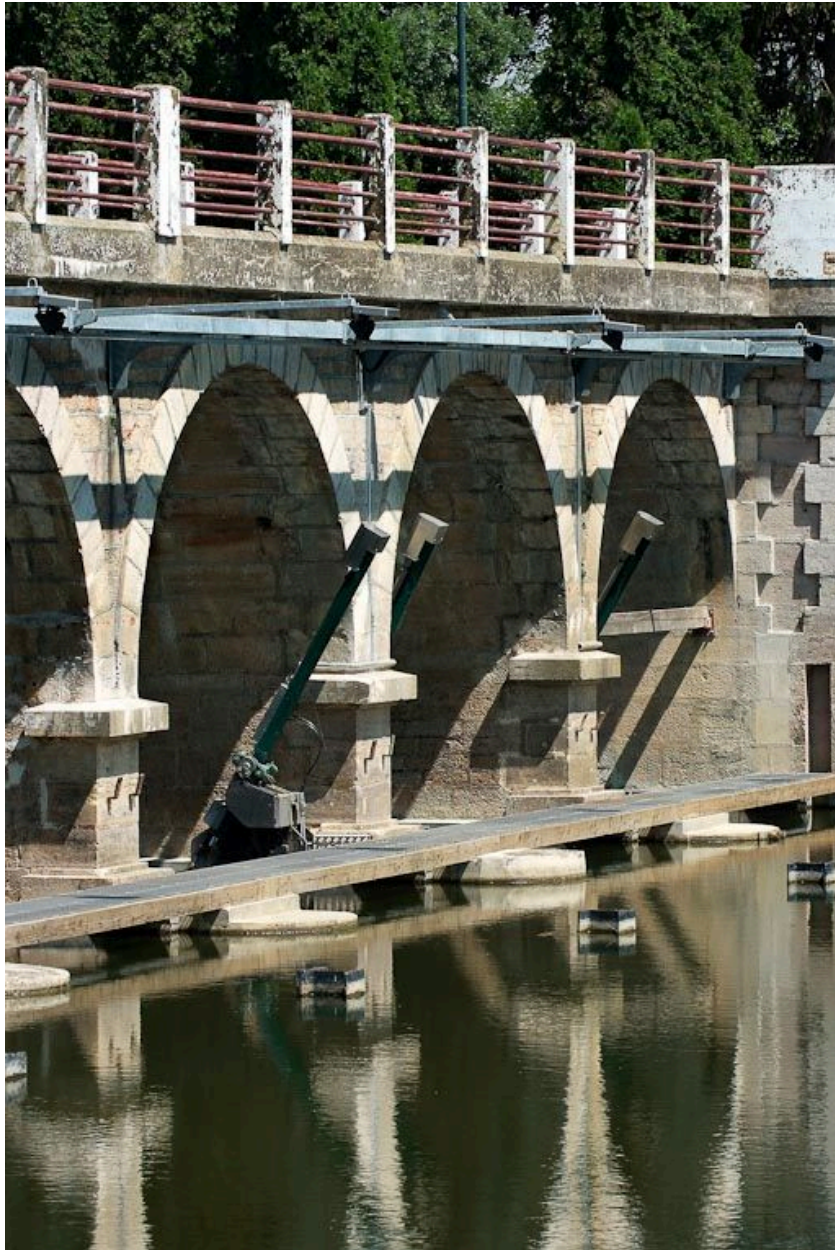
Vue rapprochée du barrage et du pont de La Truchère : plusieurs arches avec détail de la passerelle pour venir manoeuvrer les aiguilles.
