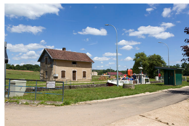
Le site d'écluse. Phot. Sonia Dourlot IVR43_20157000938NUC2A
