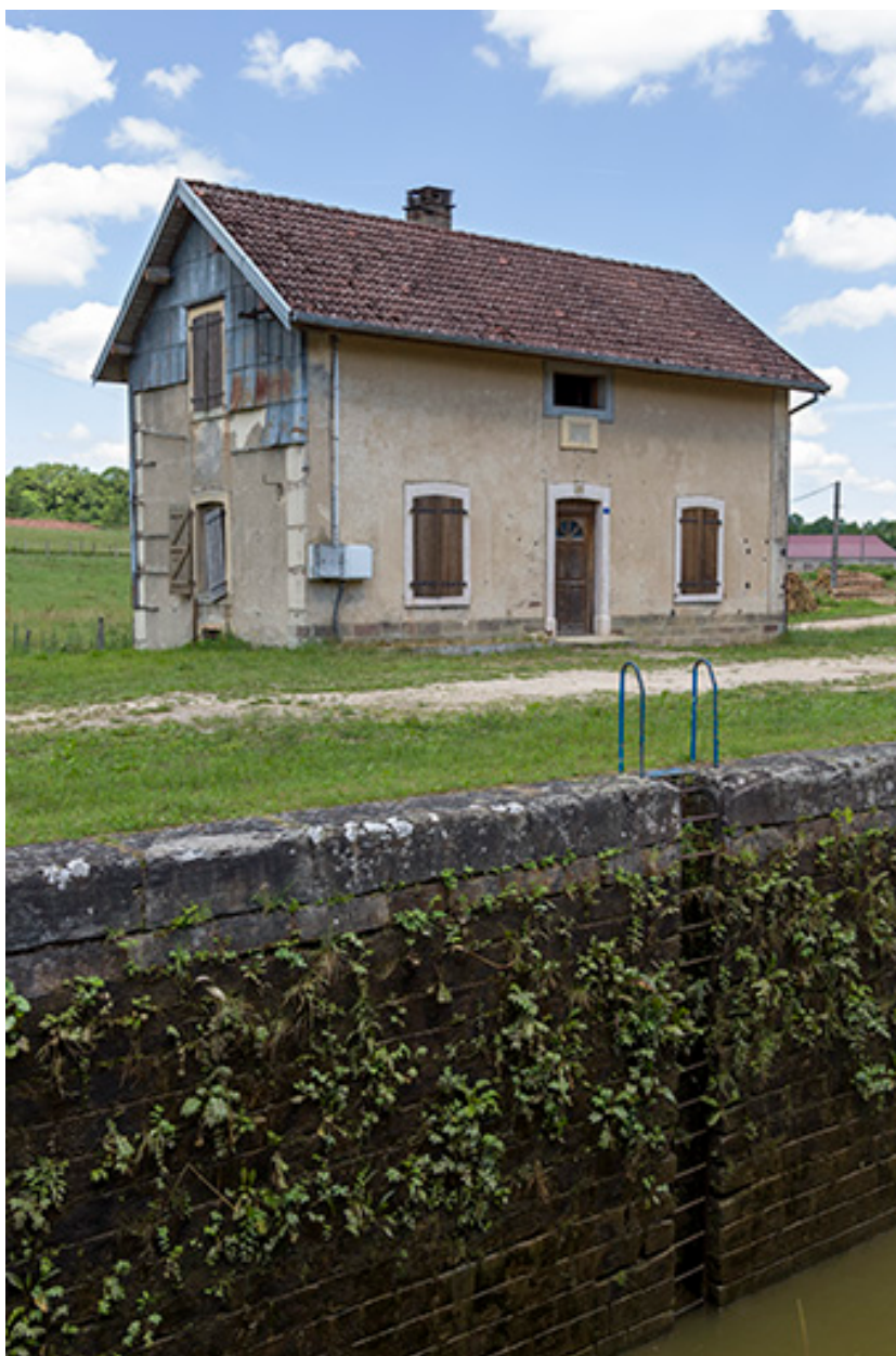
La maison d'éclusier, depuis l'écluse.
