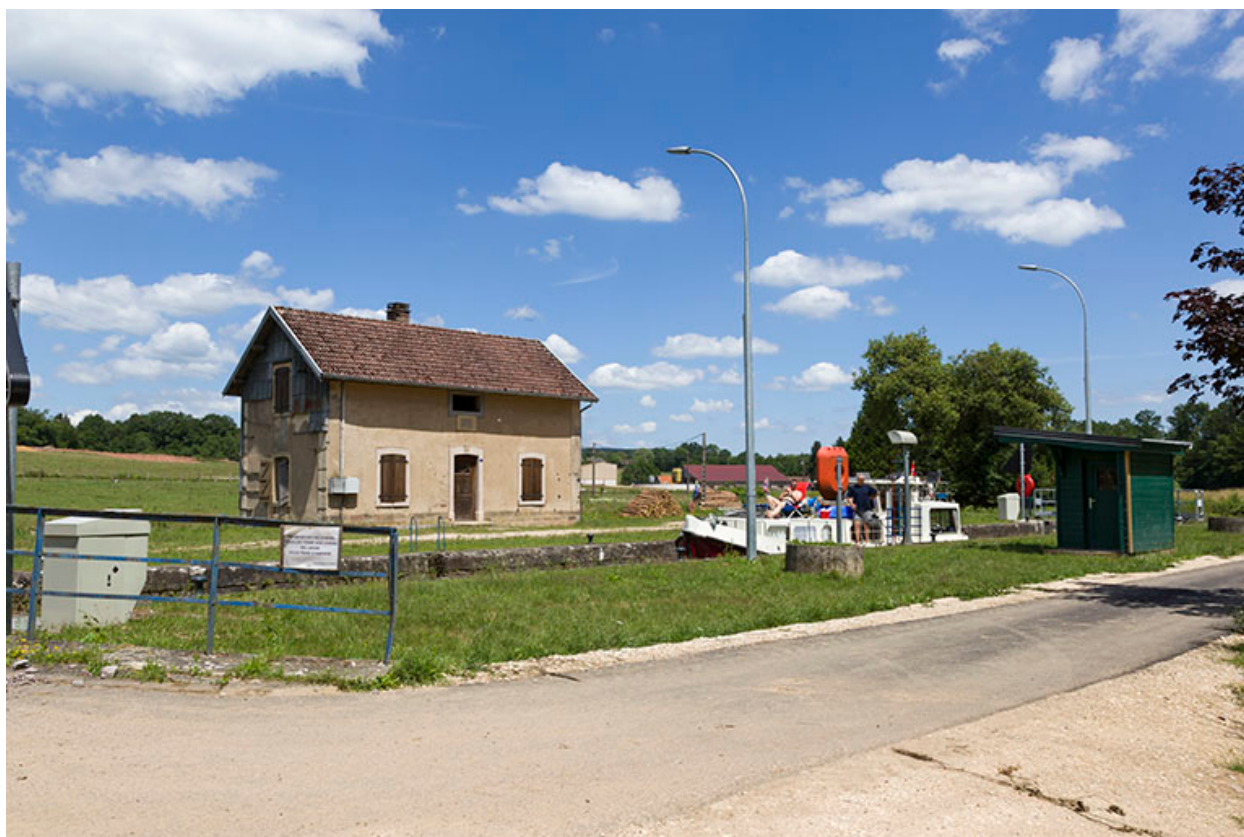
Le site d'écluse.
