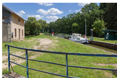
L'écluse depuis le pont. Phot. Sonia Dourlot IVR43_20157000939NUC2A
