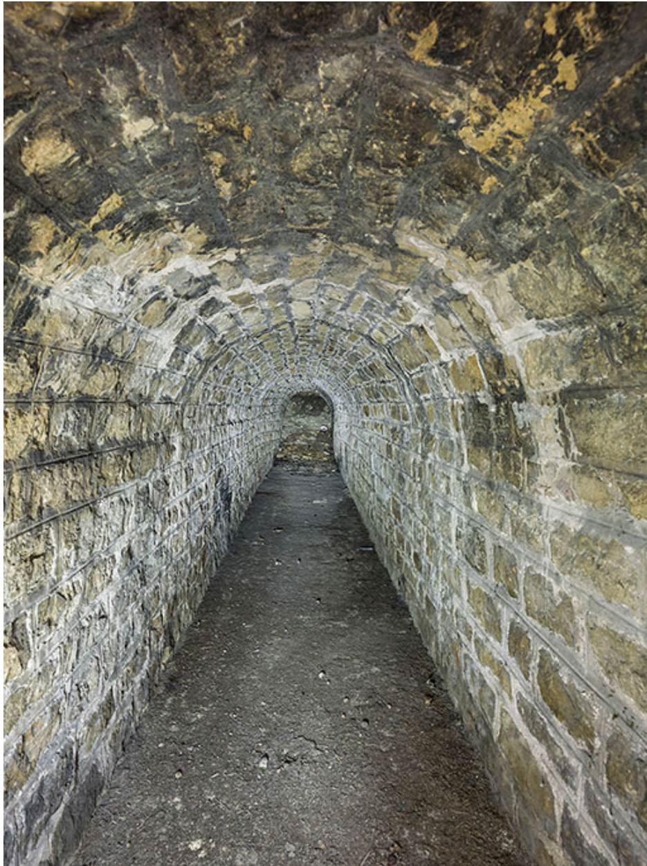
Galerie de la poterne (face).
