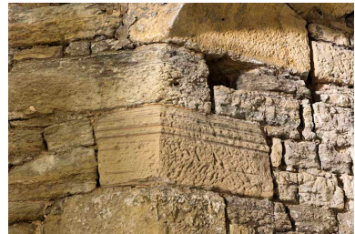
Détail de maçonnerie.
