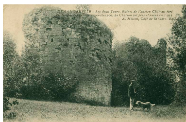
Les deux tours. Ruines de l'ancien chateau-fort. Carte postale ancienne. Phot. Jérôme Mongreville IVR43_20157000493NUC4A
