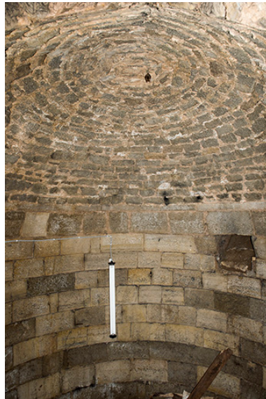
Dans la tour ouest. Niveau inférieur : citerne?
