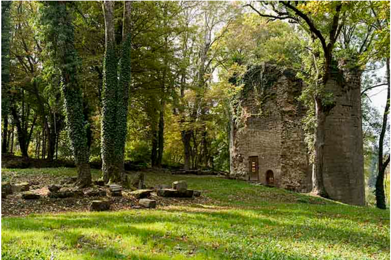
La tour ouest, vue de l'est.
