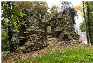
Vue sur la tour est. Phot. Sonia Dourlot IVR43_20157001325NUC4A
