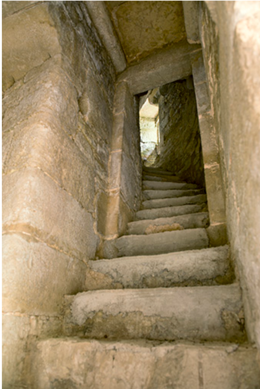
La tour ouest. Vue intérieure de l'escalier.
