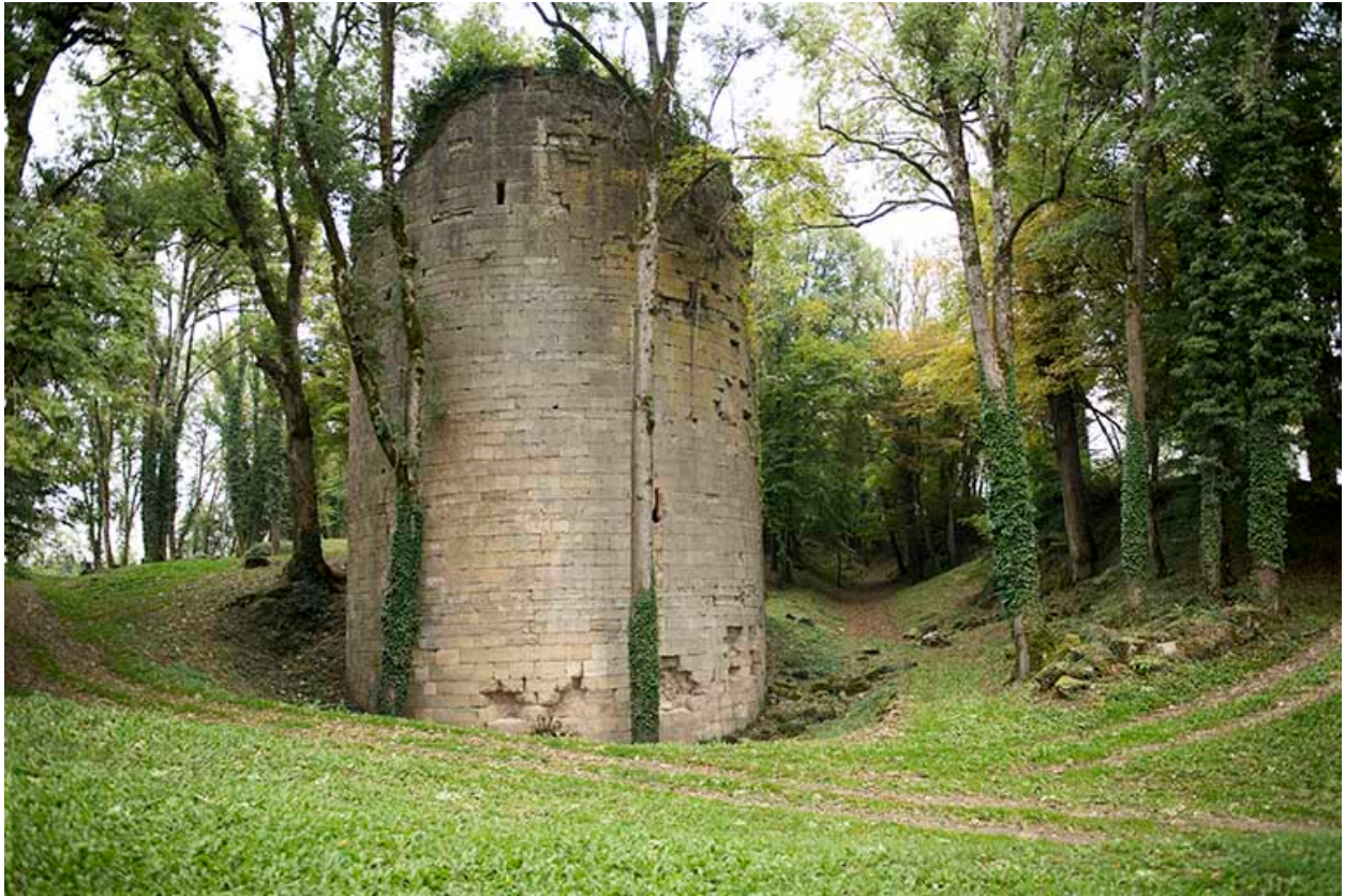
La tour ouest, vue de l'ouest.
