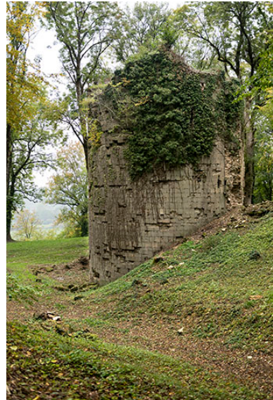
La tour ouest : vue rapprochée du sud. Phot. Sonia Dourlot IVR43_20157001334NUC4A
