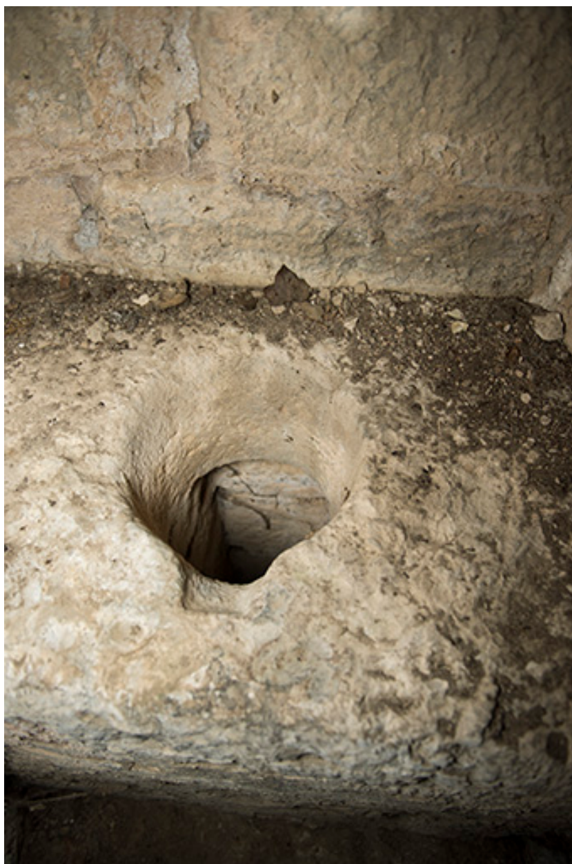
Dans la tour ouest. Détail de latrines.
