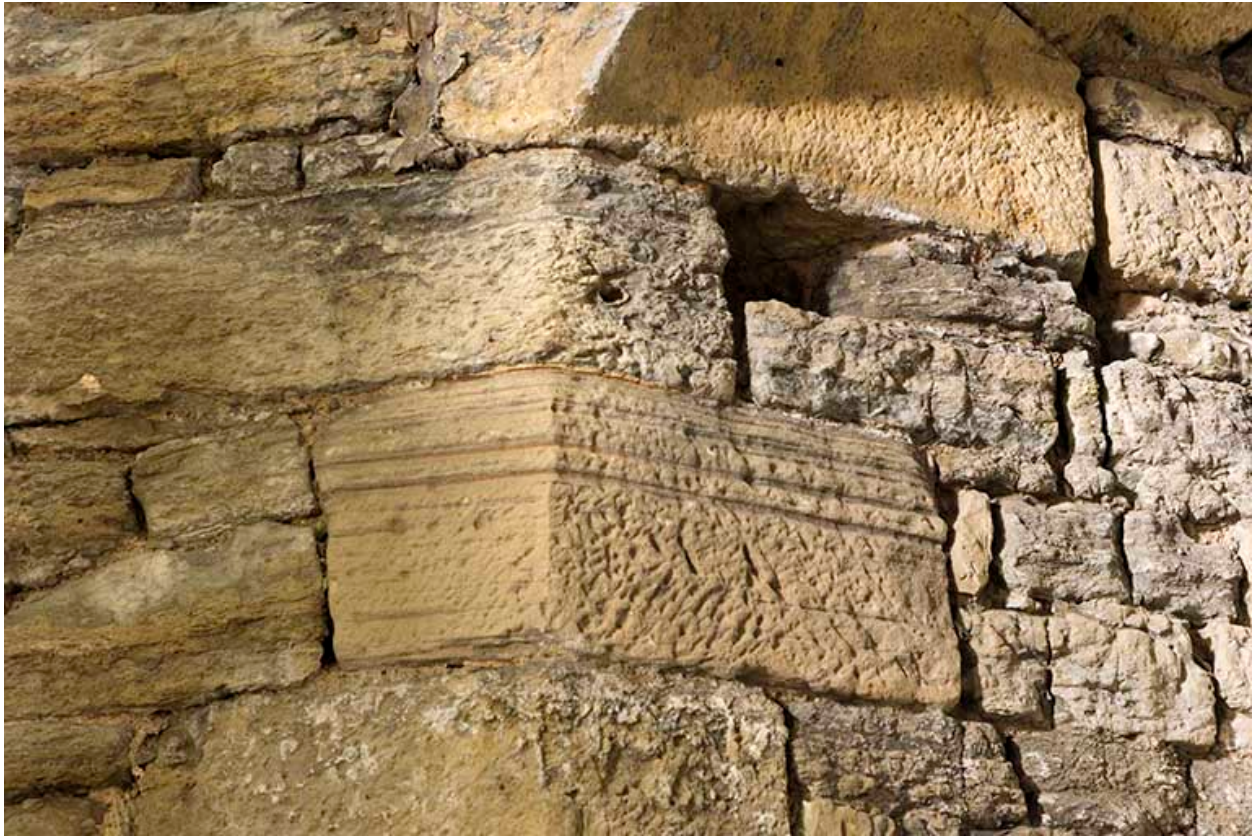
Détail de maçonnerie.
