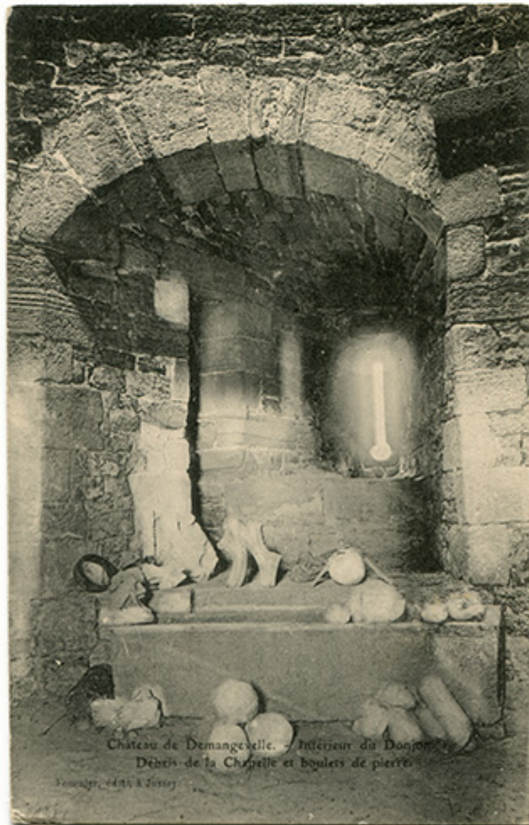
Chateau de Demangevelle. intérieur du donjon. Carte postale ancienne.
