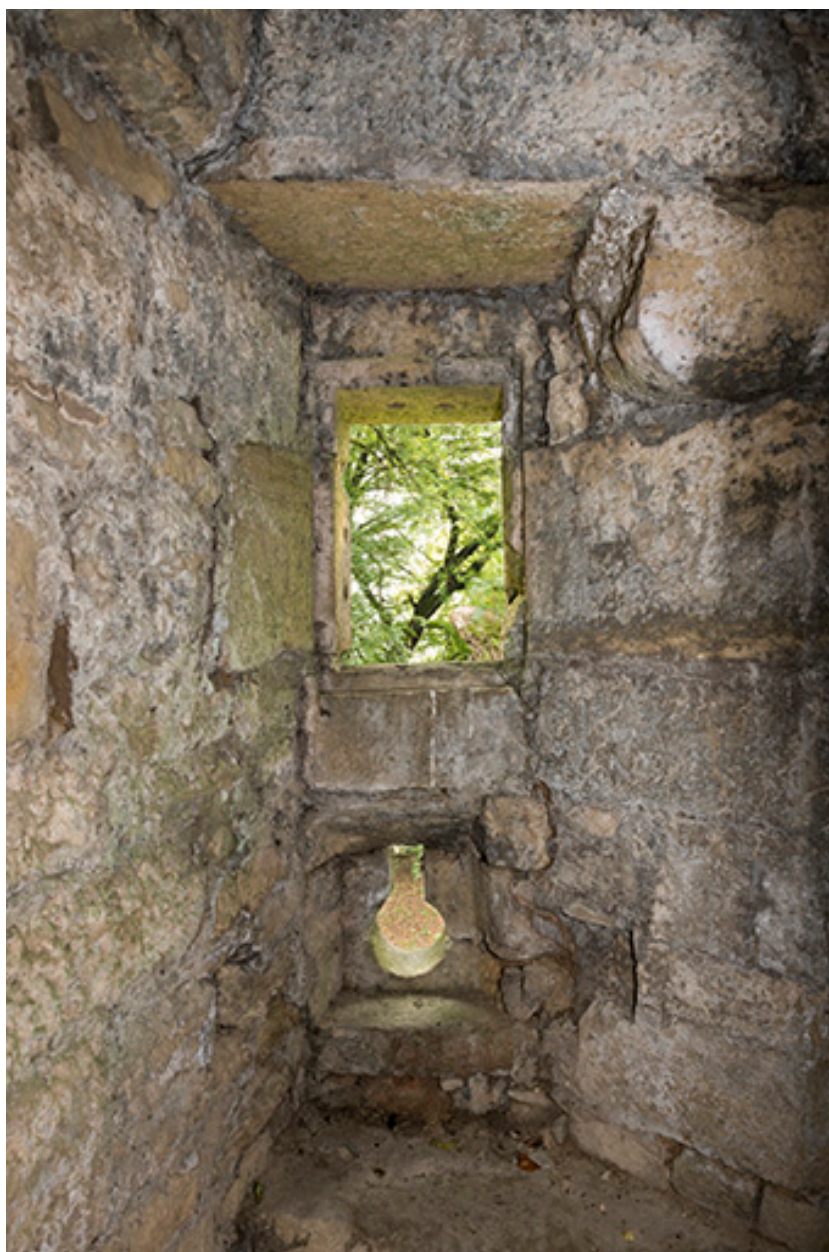
Dans la tour ouest : meurtrière, canonnière.
