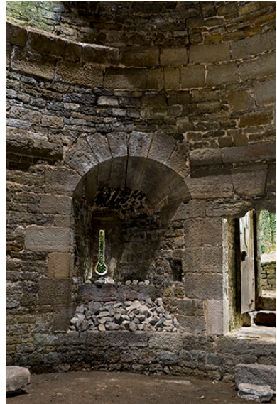
Dans la tour ouest : meurtrière, archère canonnière.
