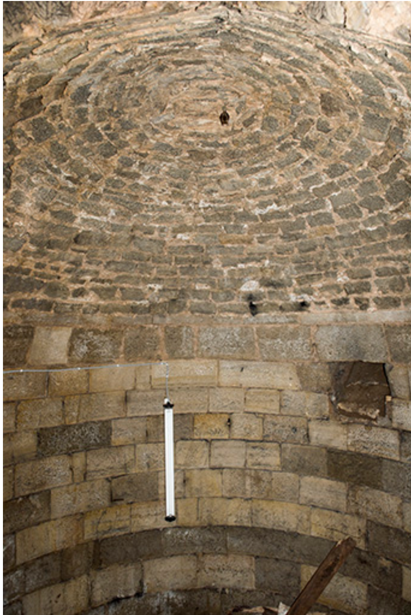
Dans la tour ouest. Niveau inférieur : citerne?
