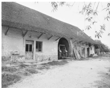
Ferme située au lieu-dit Labdedugue. Phot. Dominique Dominguez IVR43_19803900257X
