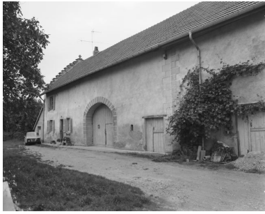
Ferme située rue Principale. Phot. Dominique Dominguez IVR43_19803900255X
