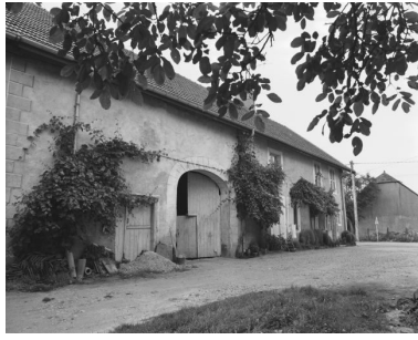
Ferme située rue Principale. Phot. Dominique Dominguez IVR43_19803900254X
