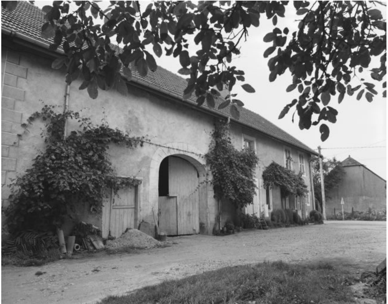
Ferme située rue Principale.
