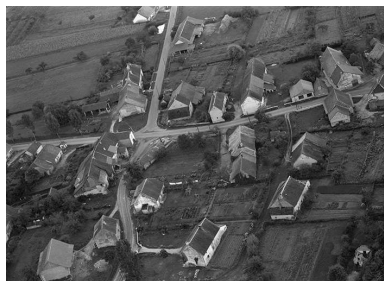
Vue aérienne d'une partie du village en 1956. Phot. Roger Henrard IVR43_19563900172N
