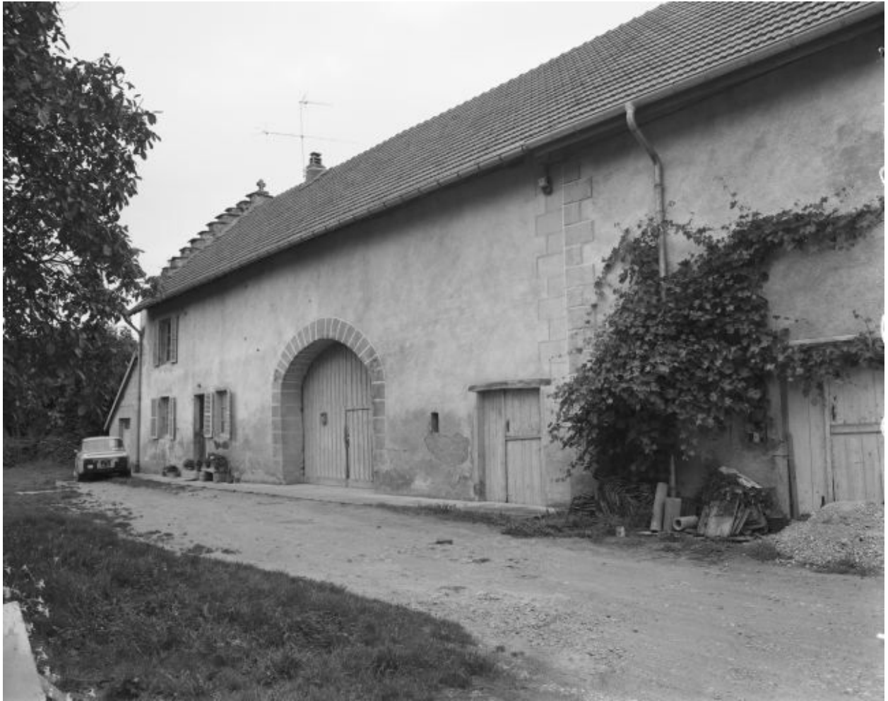
Ferme située rue Principale.
