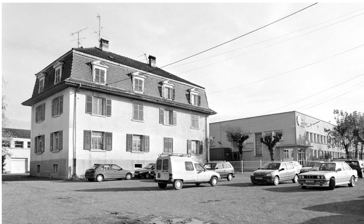
Logement (anciens bureaux) et atelier de fabrication.
