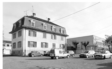
Logement (anciens bureaux) et atelier de fabrication. Phot. Yves Sancey IVR43_20009000931X
