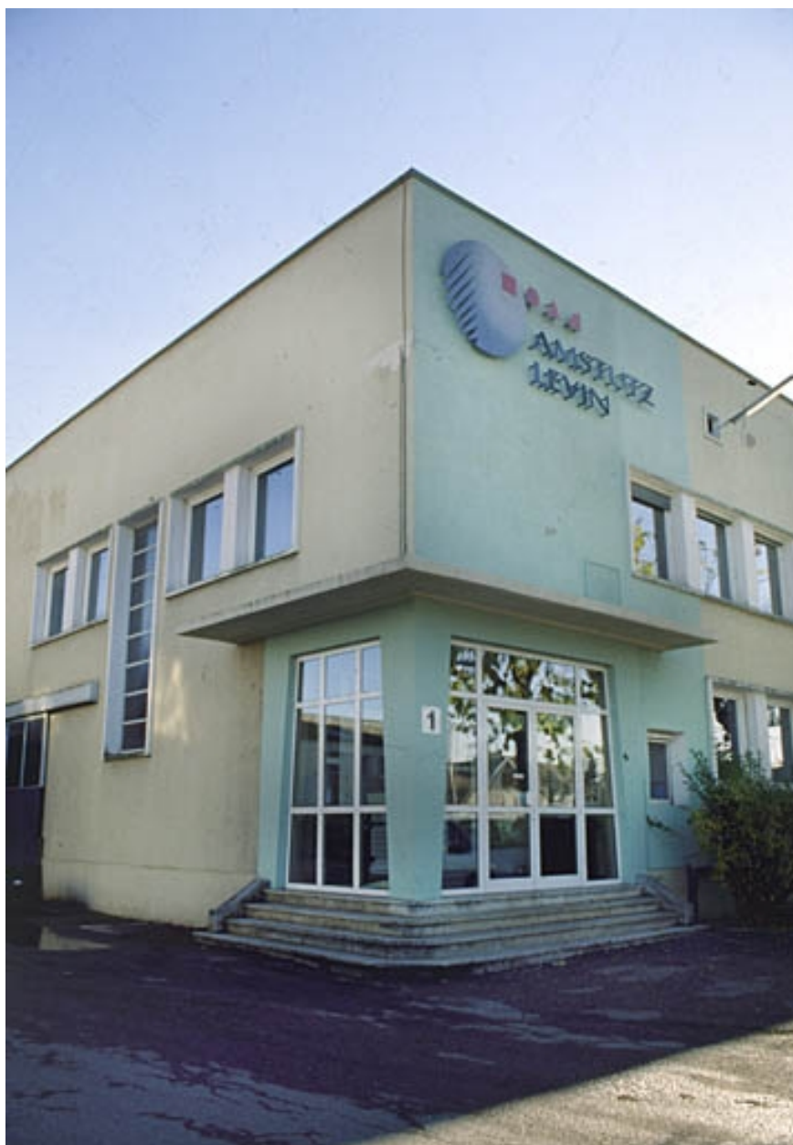
Entrée du bâtiment administratif d'entreprise.
