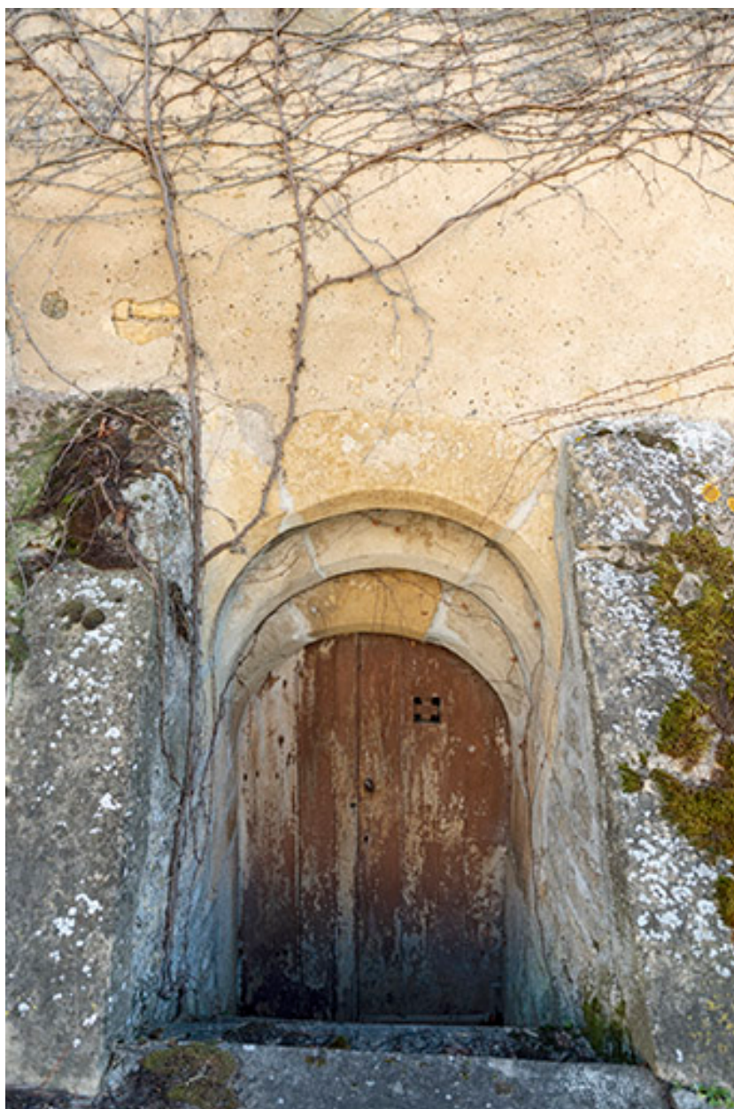
Entrée de cellier à arc en plein cintre, à ressauts formé de trois rouleaux.
