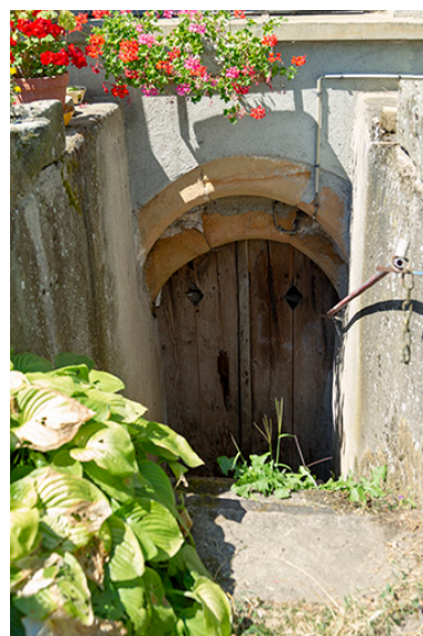
Entrée de cellier à arc en plein cintre, à ressauts formé de deux rouleaux. (4 rue du Château.) Phot. Sonia Dourlot IVR43_20167001885NUC2A
