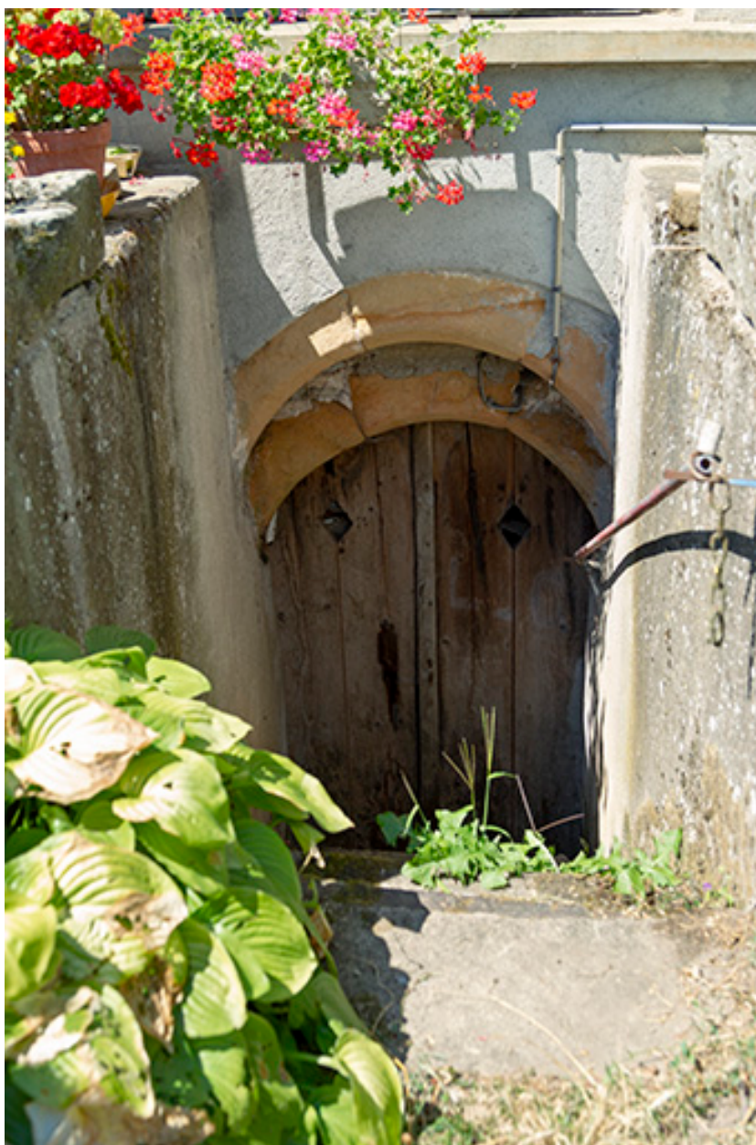
Entrée de cellier à arc en plein cintre, à ressauts formé de deux rouleaux. (4 rue du Château.)
