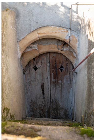
Entrée de cellier à arc en plein cintre, à ressauts formé de deux rouleaux.
