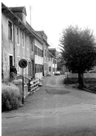
Ensemble de l'alignement. Phot. Bernard Lardière IVR43_19829000131Z
