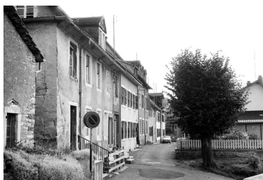
Ensemble de l'alignement. Phot. Bernard Lardière IVR43_19829000130Z
