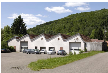
Atelier de fabrication vu depuis l'est. Phot. Jérôme Mongreville IVR43_20057000357NUCA
