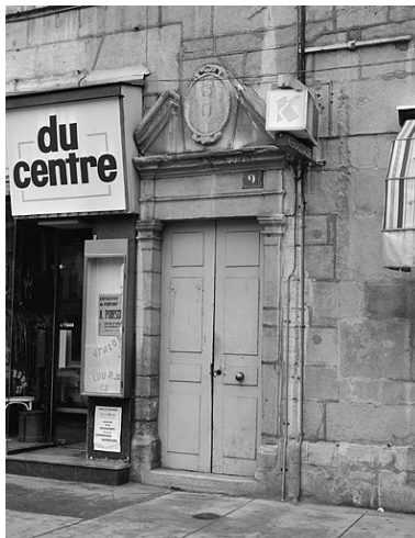
Façade antérieure, porte d'entrée avec date 1709 sur le fronton. Phot. Yves Sancey IVR43_19833900208X
