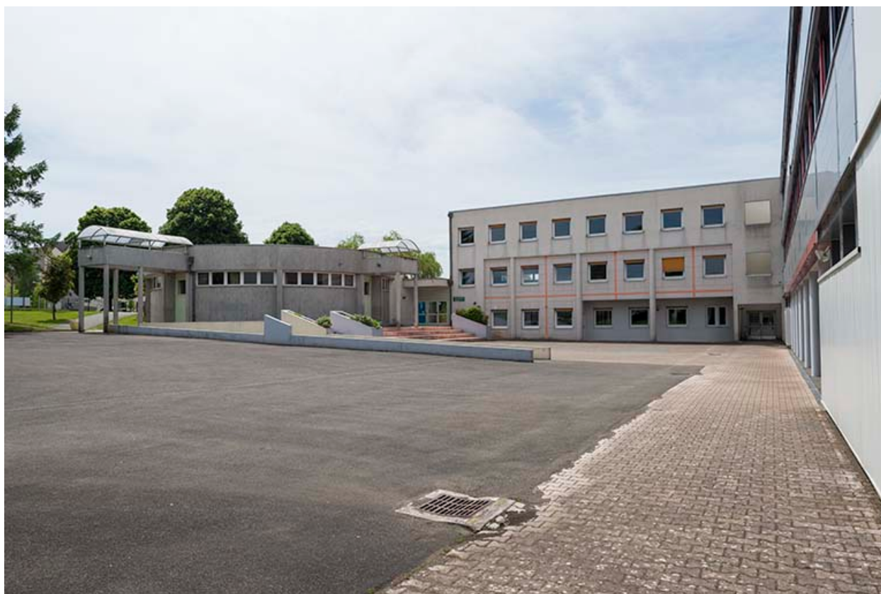
La cour vue du nord-est.
