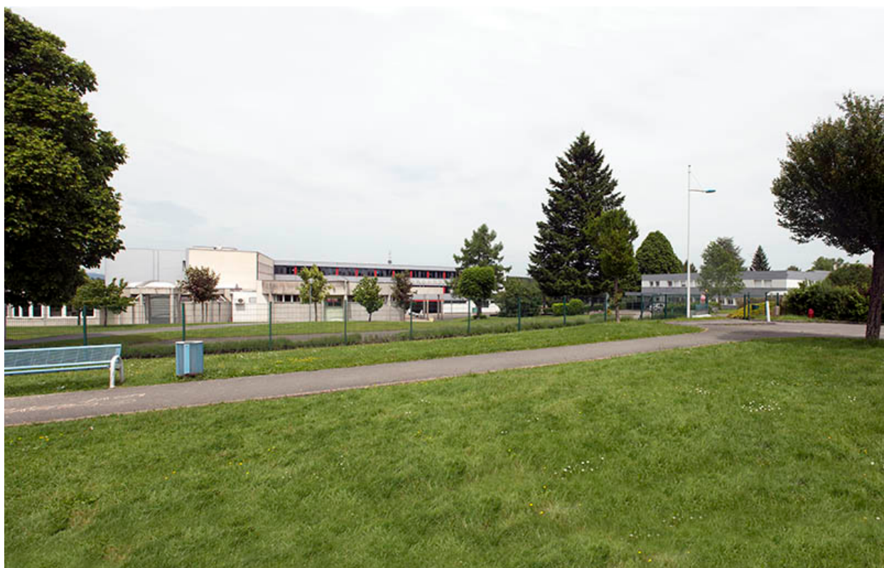
Vue d'ensemble depuis la placette au sud.
