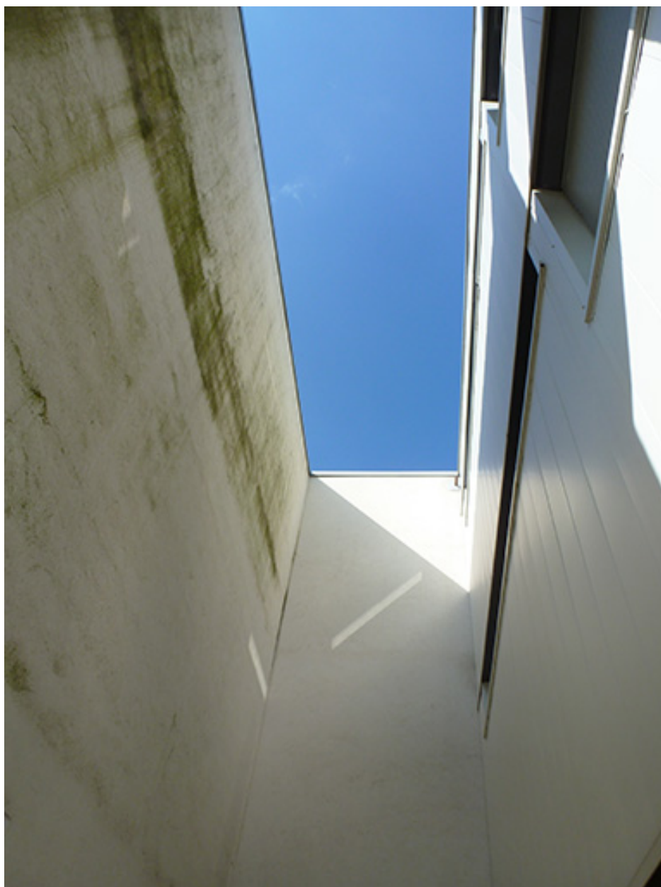
Détail architectural à la jonction des externats.
