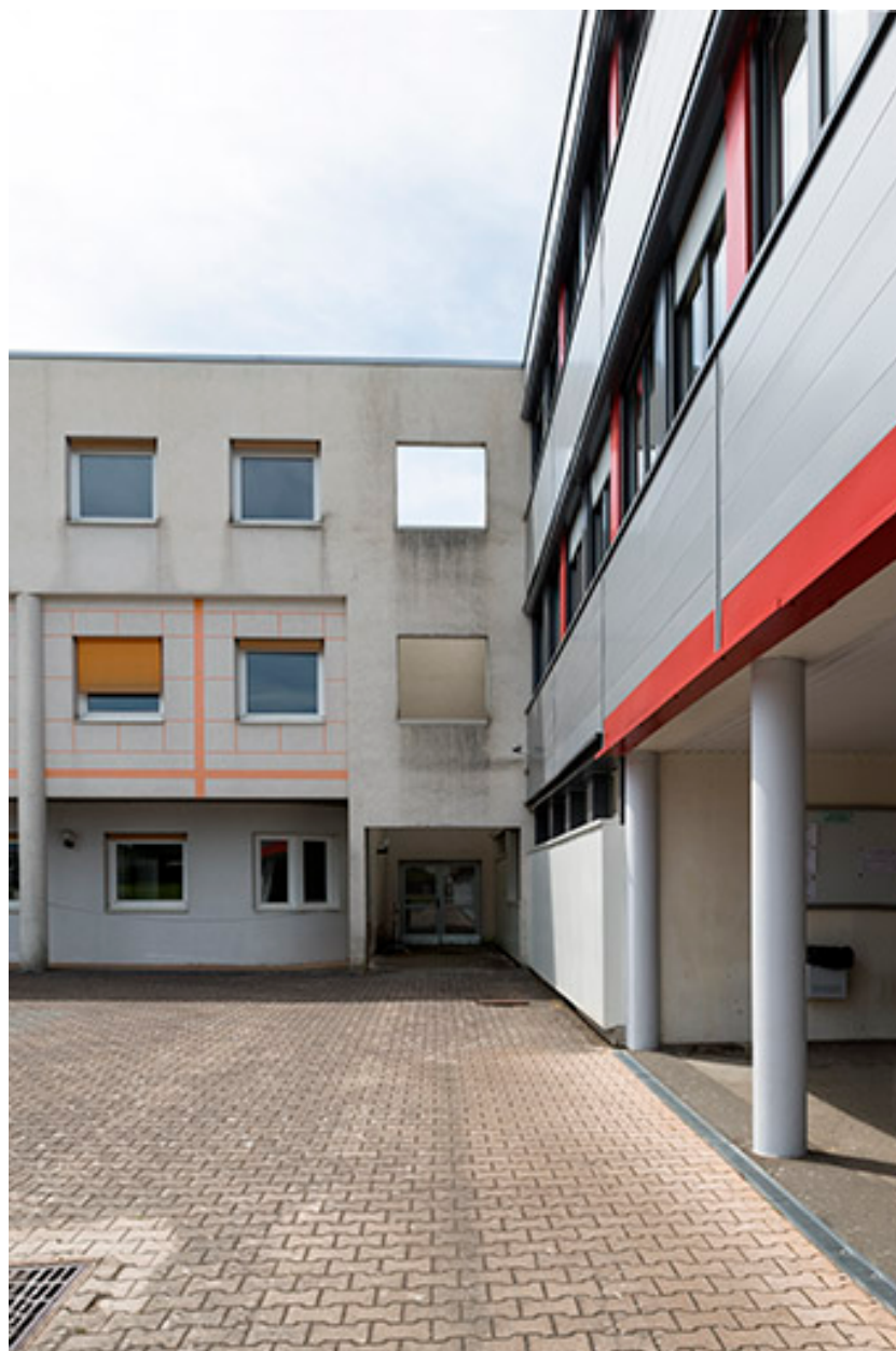
Angle intérieur nord-ouest de la cour.
