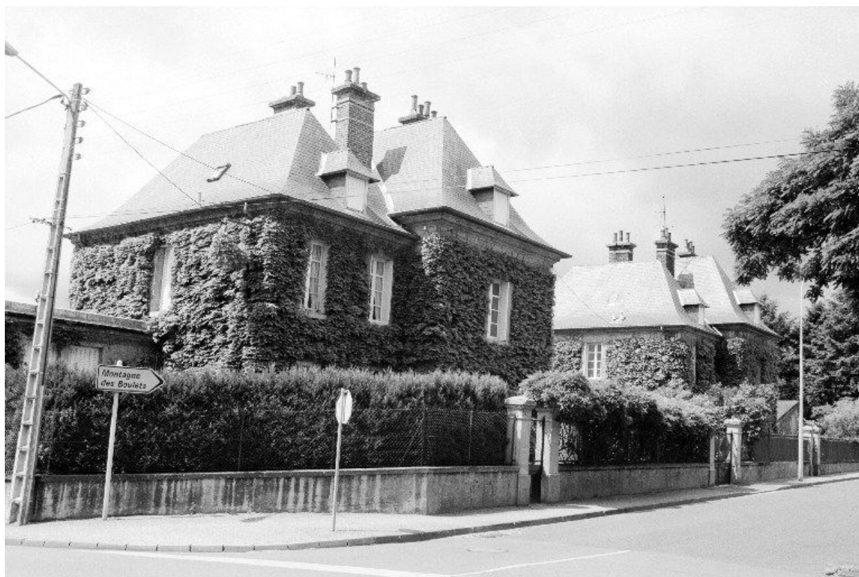
Pavillons des contrôleurs rue du 19 mars 1962, vus de l'est.
