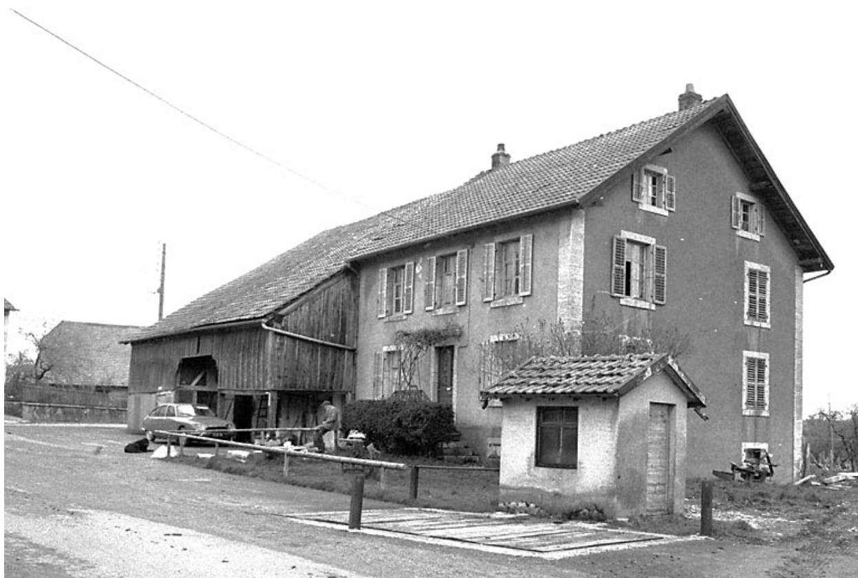
Ferme de 1902 : vue d'ensemble.
