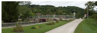
Vue du pont depuis l'amont. Phot. Pierre-Marie Barbe-Richaud IVR26_20112104053NUC4AQ
