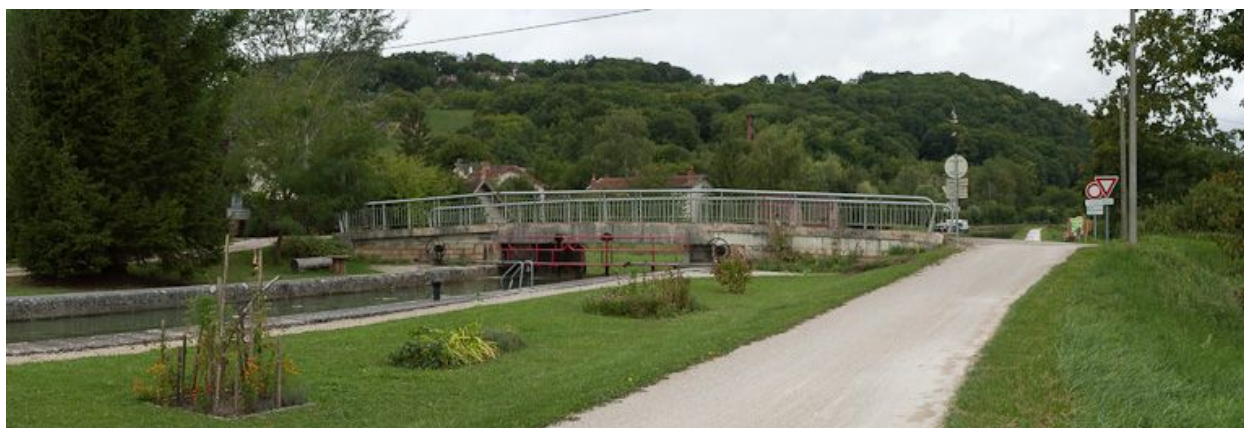
Vue du pont depuis l'amont.
