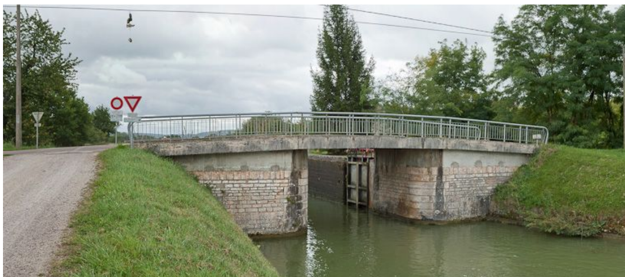
Vue du pont depuis l'aval.
