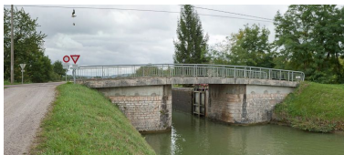
Vue du pont depuis l'aval. Phot. Pierre-Marie Barbe-Richaud IVR26_20112104055NUC4AQ
