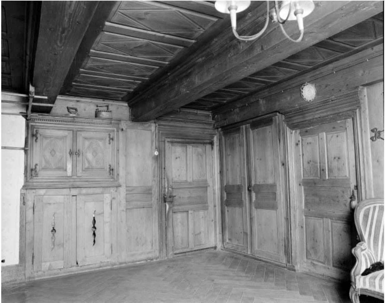
Intérieur : le "poêle", placards et boiseries.
