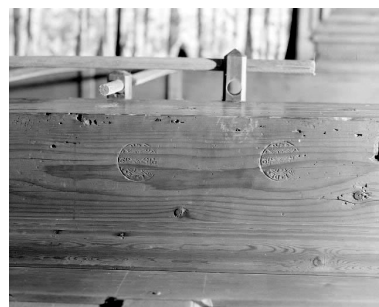
Intérieur : le "poêle", détails : sceaux du val de Morteau. Phot. Dominique Humbert IVR43_19762500598X
