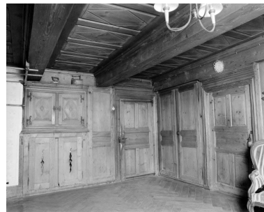
Intérieur : le "poêle", placards et boiseries. Phot. Dominique Humbert IVR43_19762500595X
