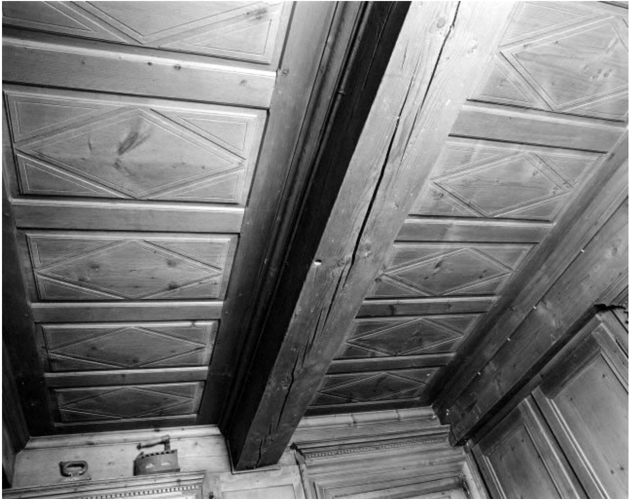
Intérieur : le "poêle", plafond.
