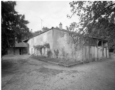
Logement annexe au fond du parc. Phot. Yves Sancey IVR43_19887000181V
