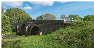
Vue du pont.
