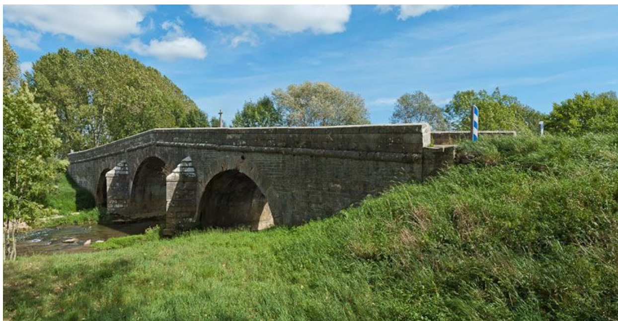
Vue du pont.
